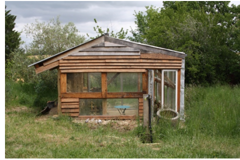
Figure 13 : Serre semi-enterrée (source : O.Delaère)
