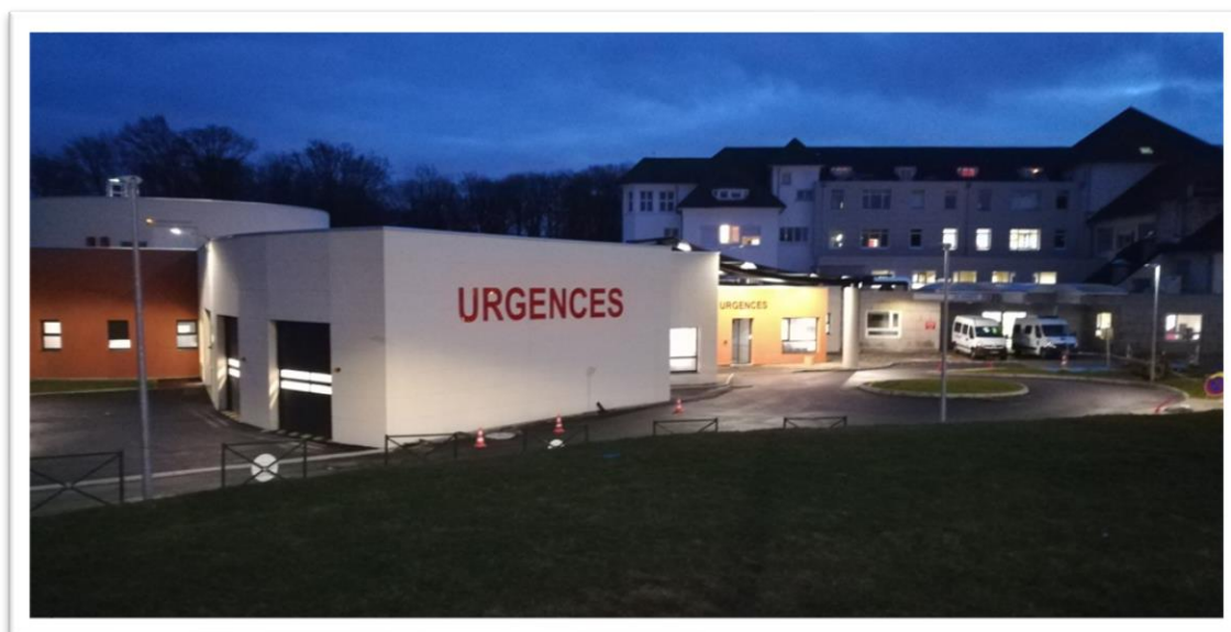
Figure 1 - Vue de l'accueil des urgences
