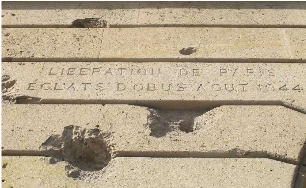
Figure 24 : Photographie de la façade côté rue de Vaugirard avec des éclats d'obus datant de la Libération et une inscription postérieure 17 .
