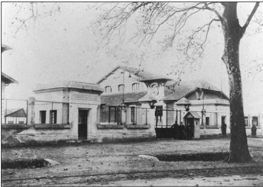
ENTRÉE PRINCIPALE - BUREAUX
