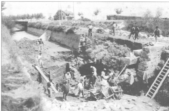
Chantier de la construction du canal
