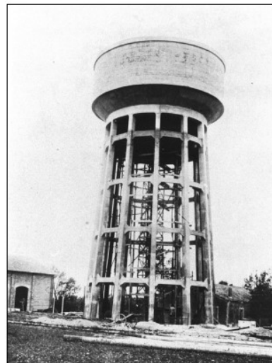
USINE A.N.S. : CHÂTEAU D'EAU
