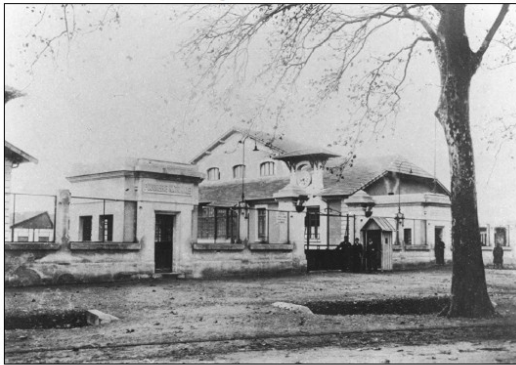
ENTRÉE PRINCIPALE - BUREAUX
