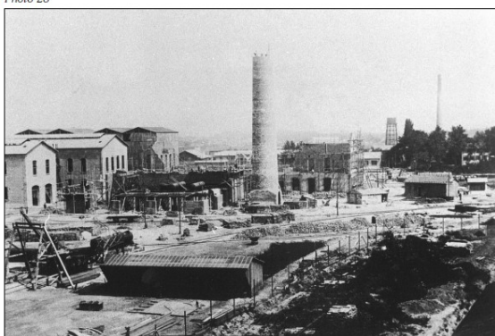
USINE A.N.S. : VUE GÉNÉRALE
