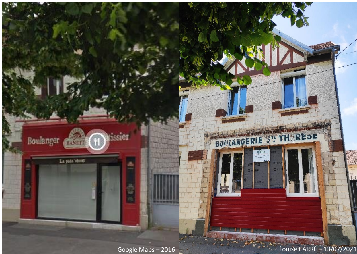
Figure 20 : Transformation d'une boulangerie en habitation –Boulevard de Rethel, Caen
