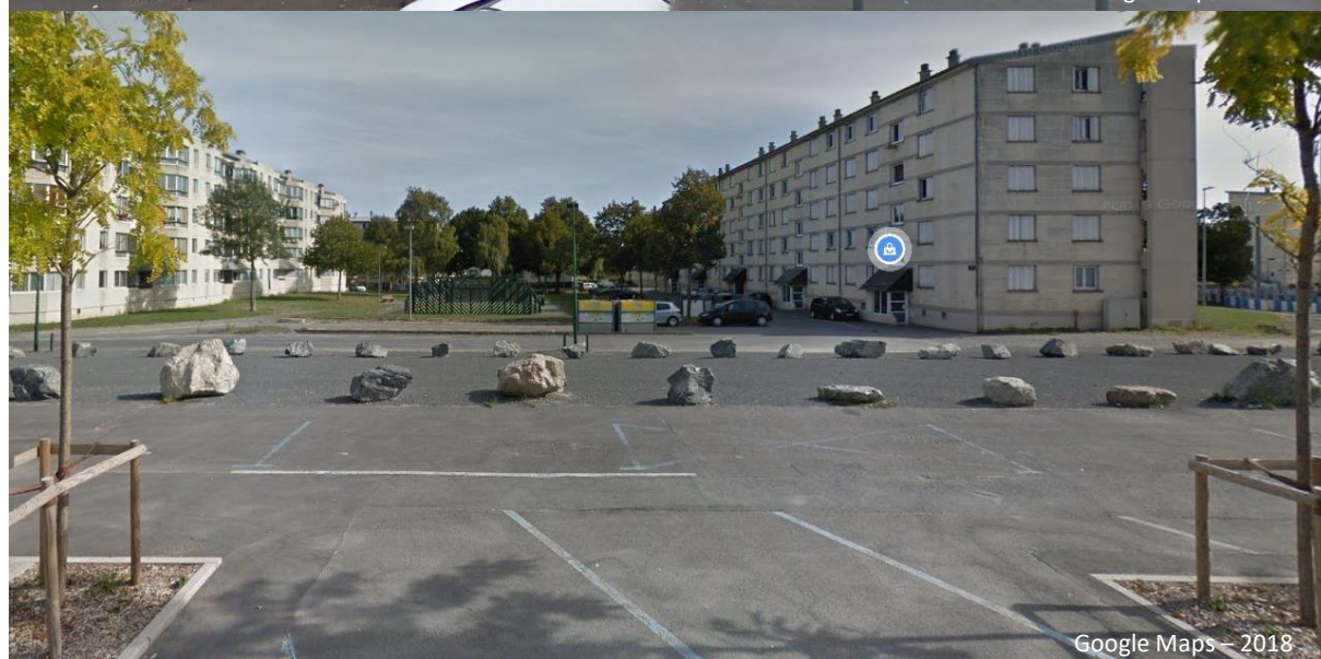
Figure 22 : Démolition d'une barre avec des commerces en rez-de-chaussée et logements à l'étage – Place de la Liberté, Caen
