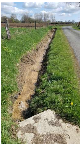
Fossé permettant l'écoulement de la parcelle jusqu'à la buse et jusqu'au cours d'eau
