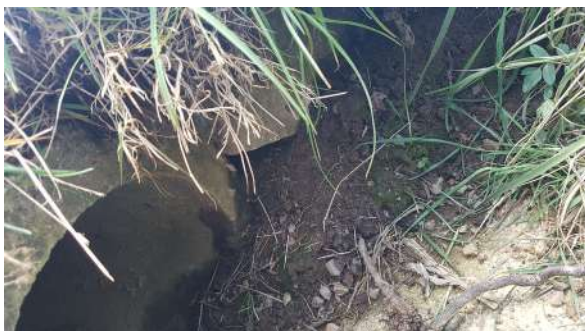
Prélèvement C1P2 : accumulation de sédiments devant la buse
