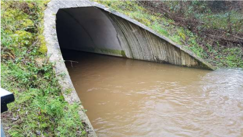
Exutoire du bassin versant (tunnel permettant le passage du cours d'eau sous l'A84)
