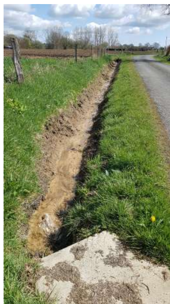
Fossé permettant l'écoulement de la parcelle jusqu'à la buse et jusqu'au cours d'eau
