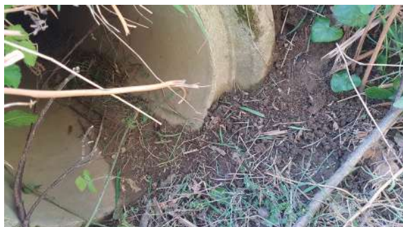
Prélèvement C2P2: accumulation de sédiments devant la buse
