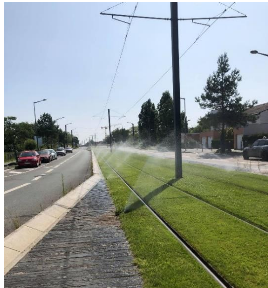
Figure 14 : Arrosage par aspersion sur la ligne A du tramway d'Angers, Bd Elisabeth Boselli (Orand, 2021)
