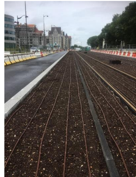
Figure 15: Mise en place de la subirrigation sur le tramway T10 à Paris (Meyer, 2021)
