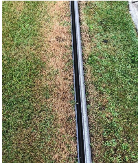
Figure 5 : Gazon jaunit aux abords des rails de la ligne A du tramway d'Angers, descente du CHU (Orand, 2021)
