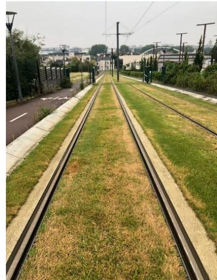
Figure 6 : Gazon de la ligne A du tramway d'Angers jauni à cause d'un manque d'eau, descente du CHU (Orand, 2021)
