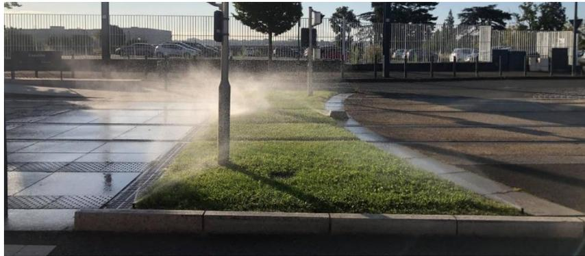
*Figure 19 : Arrosage d'une petite bande engazonnée avec des tuyères sur la ligne A du tramway d'Angers, Rue des Capucins (Orand, 2021)*
