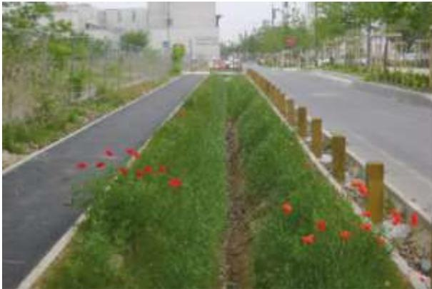
Figure 16 : Exemple de noue en bordure de chaussée à Cergy Pontoise (source : Les Cahiers Techniques du bâtiment, 2016).
