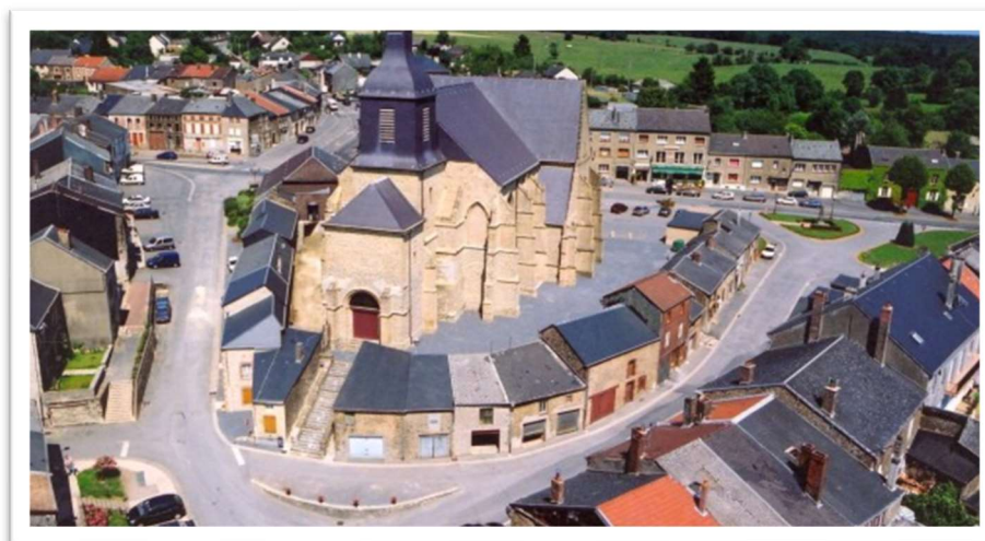
Figure 6 Paroisse Saint Hubert des Aulnes © Mairie de Renwez (08)
