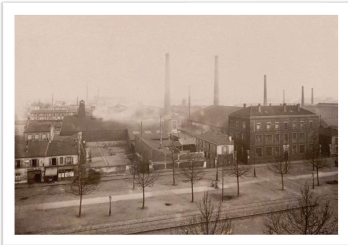
Figure 43 Vue générale de l'Usine Mouton en 1895
