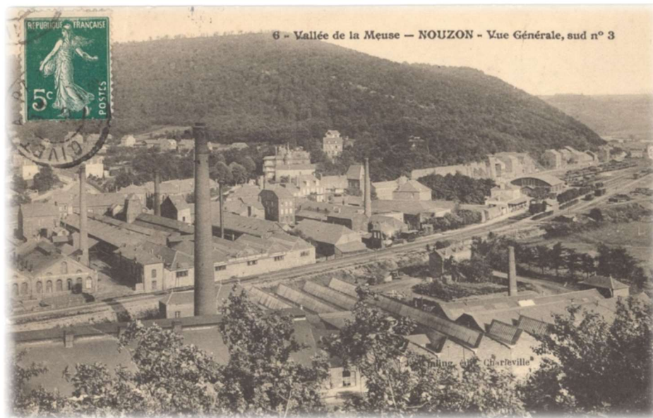
Figure 46 Nouzonville - Vue aérienne des 3 usines Thomé AD08 & Fi 7 S.d.
