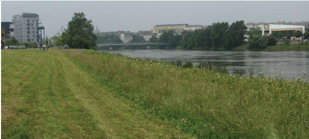
Figure 27 : Renaturation du quai François Mitterrand à Nantes (Source : Biotec, 2005)
