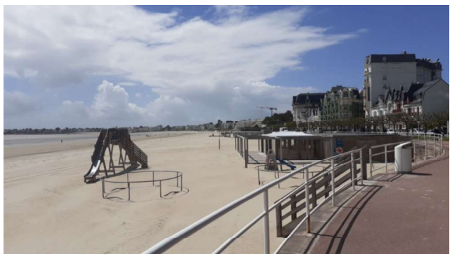
Figure 12 : Vue depuis le remblai (Source : Explorations Architecture, 2021)
