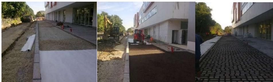
Figure 54. Réalisation d'une chaussée perméable en pavés de béton posés sur une structure en grave drainante et mélange micro-terre pierre (rue du Château-du-Loir, à Courbevoie (Photos EONO David, 2009)
