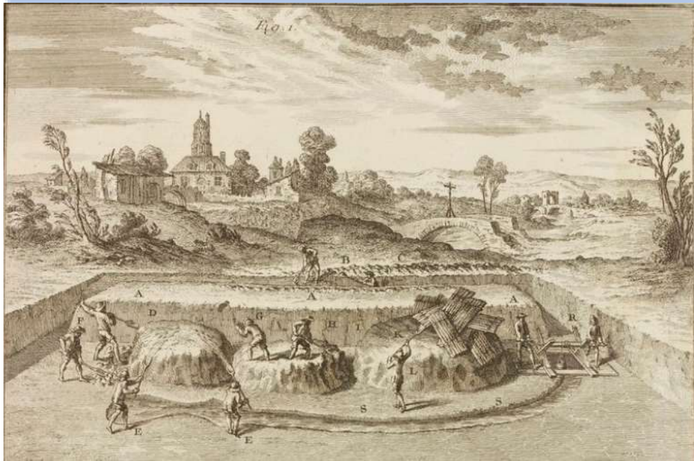
Travail de la terre dans la fosse-le « corroyage »
