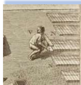
Mise au séchage des tuiles moulées
