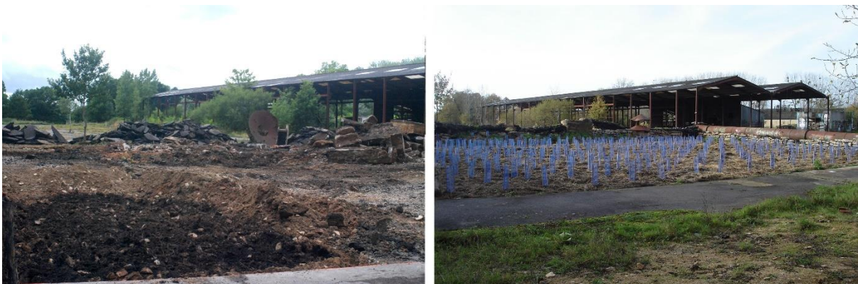
Figure 34 : Photographies de la phase chantier et à la suite de la plantation du Bosquito (source : Laure Vidal-Beaudet)
