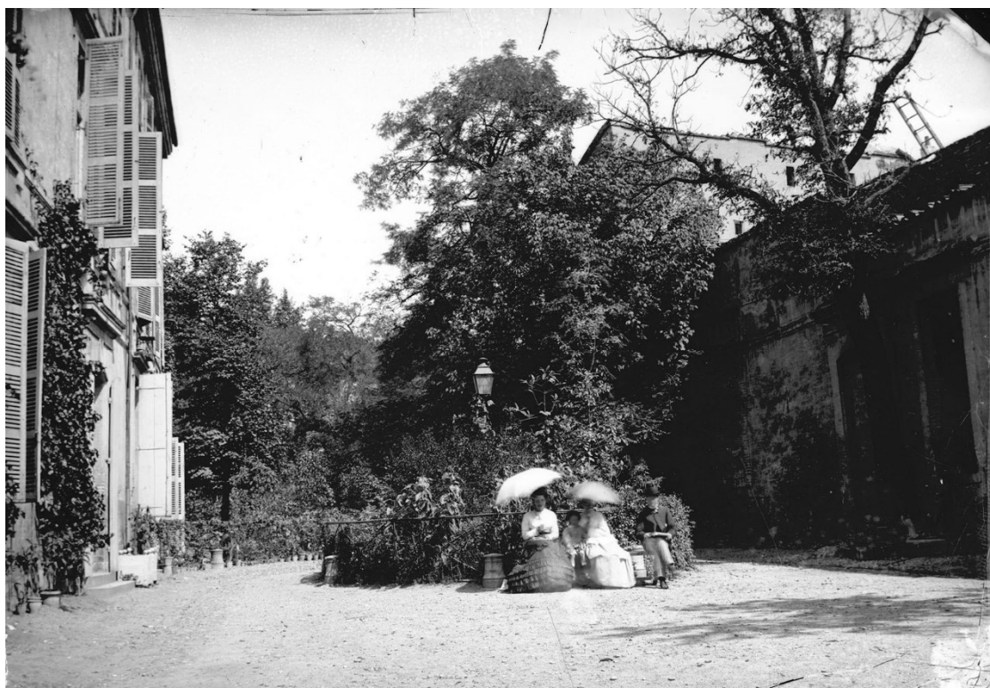
Photo de la Cour, 11 rue d'Astorg, entre 1869 et 1871 197
