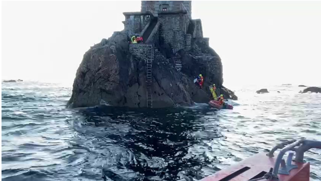
Figure 3.11 : L'accès au phare de Triagoz se fait par deux voies : l'échelle verticale, ou l'escalier taillé dans la roche débouchant sur une calle émergée uniquement à marée basse. Photo issue de l'expérimentation du 14/07/2021.
