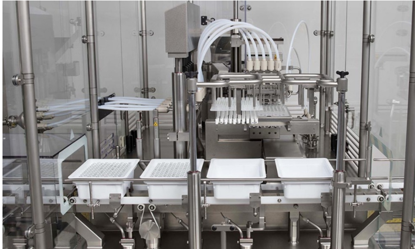
Figure 10 : Remplisseuse automatique (photographie prise sur site)
