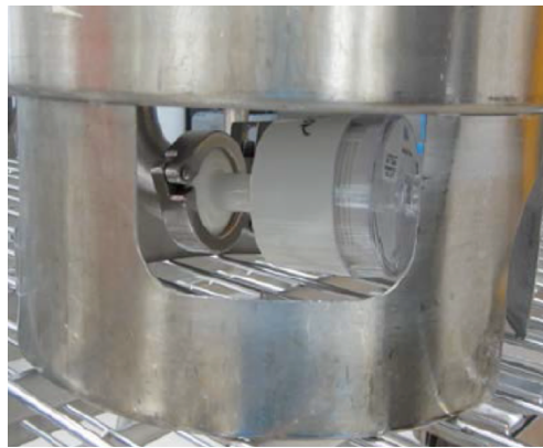
Figure 45 : Filtre à air fixé au canister (photographie prise sur site)
