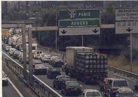
En l'an 2000, la circulation sur la voie sur berge atteindra 95 000 véhicules par jour, en l'absence d'un contournement nord.
