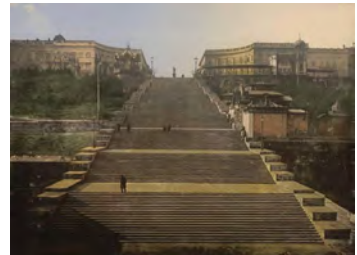
Fig 20 : L'escalier du Potemkine, photo prise entre 1890 et 1900. Le point de vue surélevé permet d'observer à la fois les marches et les paliers
