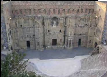
Fig 41 : Tribune en escalier antique, ancien cirque grecque
