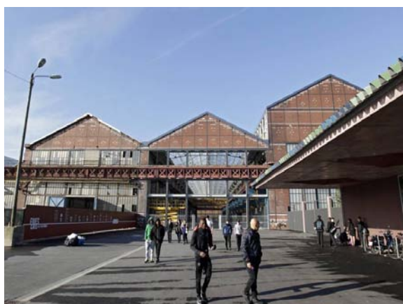
Figure 124 : Vue de la partie réhabilitée de l'usine Five-Cail-Babcock
