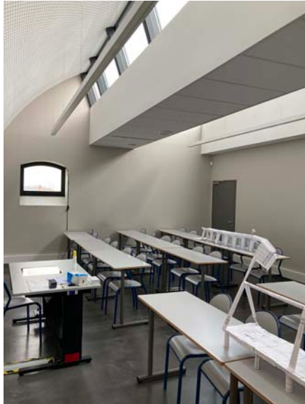
Figure 266 : Vue des sheds dans la salle de classe
