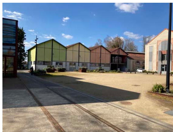
Figure 131 : Vue de l'usine Tréfinmétaux réhabilitée depuis la Cour des 12 femmes en colère
