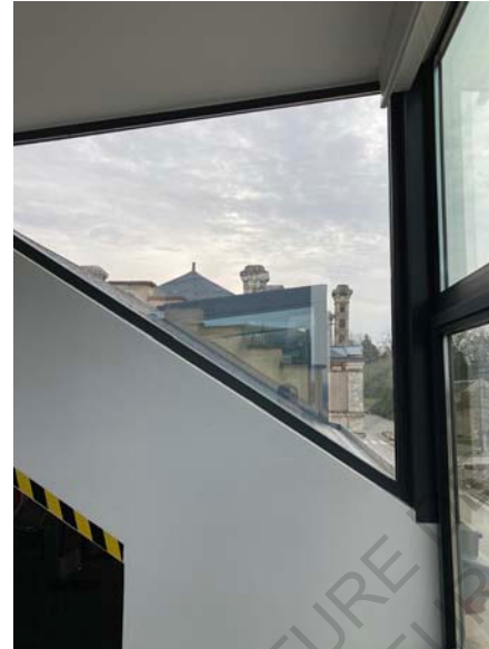
Figure 250 : Vue des autres décrochés sur le toit
