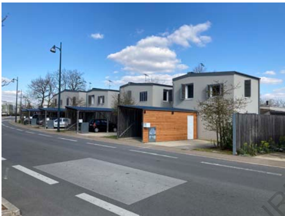
Figure 111 : Vue des maisons construites faisant partie de la phase 3 du projet
