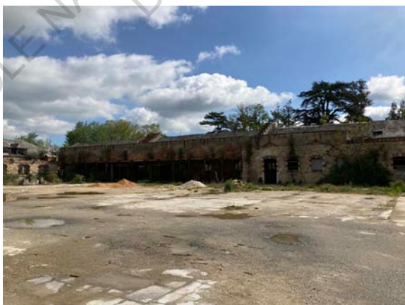
Figure 320 : Vue existante Est du Carreau Est
