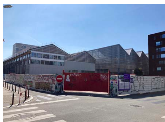
Figure 86 : Vue du chantier de réhabilitation des Halles Alstom
