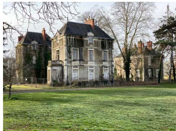
Figure 396 : Vue des maisons de cadres de l'usine Balsan
