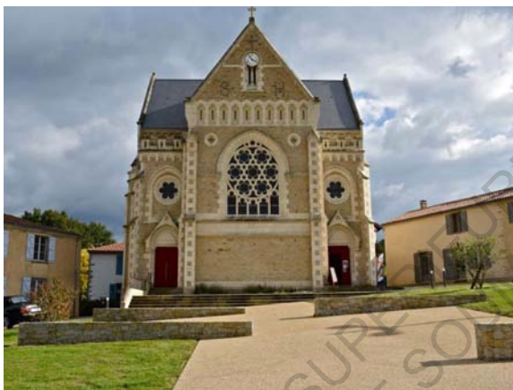
Figure 283 : Vue extérieure de l'église Saint-Hilaire-de-Mortagne
