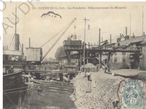
Figure 193 : Vue du débarquement du minerai de la fonderie en 1914 (AM de Couëron, 6Fi78)
