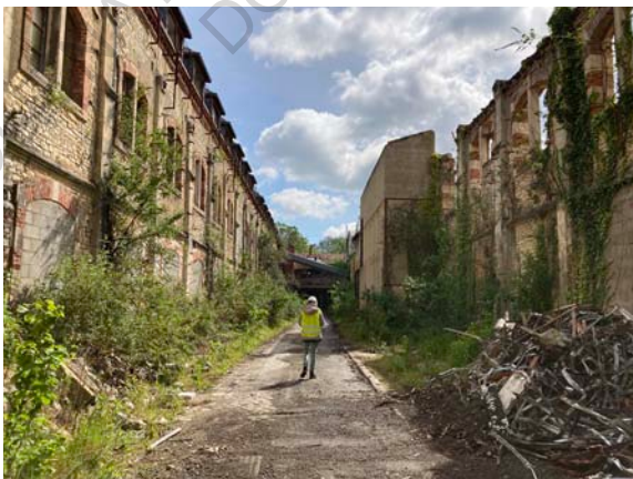
Figure 395 : Vue du bâtiment du Flockage
