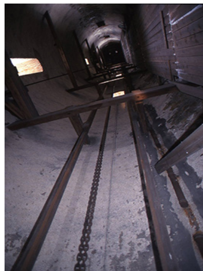
Figure 378 : Vue du monte-charge de la Tour à plomb
