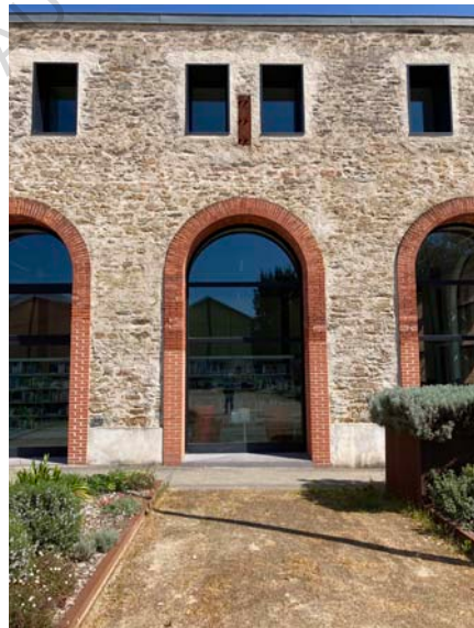
Figure 269 : Vue extérieure des fenêtres restaurées
