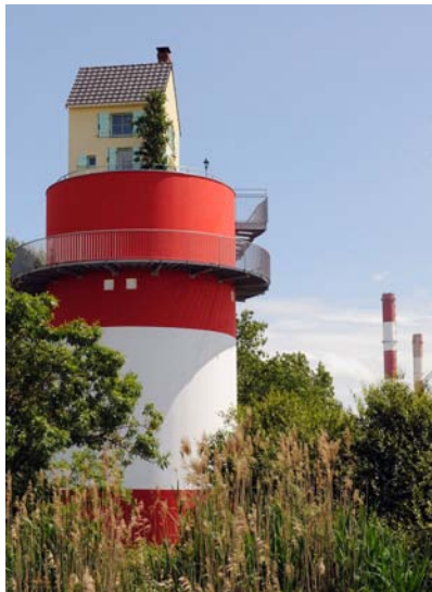
Figure 77 : Vue de la Villa Cheminée à Cordemais
