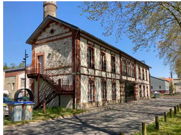
Figure 256 : Vue de la Fonderie depuis le quai Jean-Pierre Fougerat
