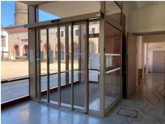
Figure 227 : Vue du hall d'entrée de la Fonderie
