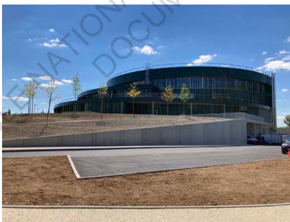
Figure 182 : Vue Nord Est de Balsan'éo
