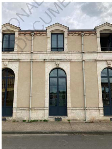
Figure 264 : Vue des fenêtres restaurées
