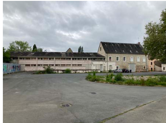
Figure 41 : Vue des anciens bâtiments administratifs
