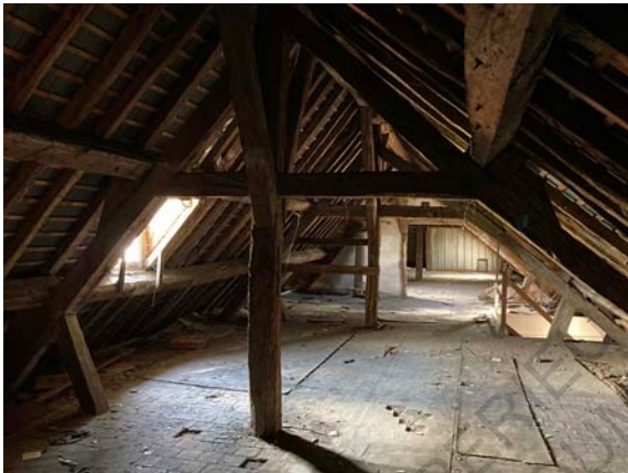
Figure 336 : Vue du niveau des combles et de sa grandeur.
