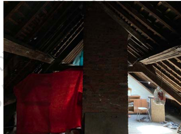
Figure 337 : Vue de l'extrémité Sud du niveau des combles
