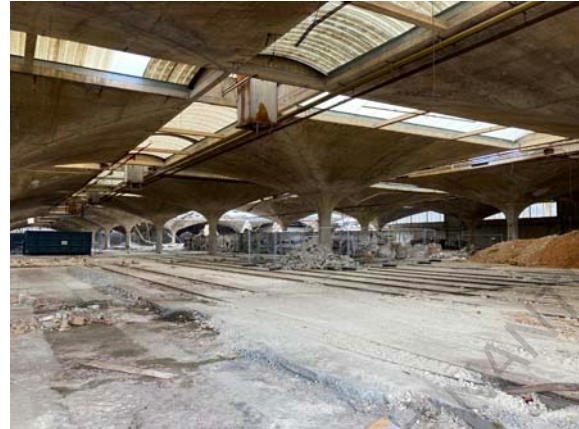
Figure 45 : Vue intérieure de l'usine Cerabati et du chantier en cours
