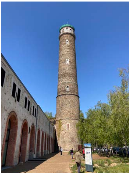
Figure 383 : Vue de la Tour à plomb de Couëron de face
