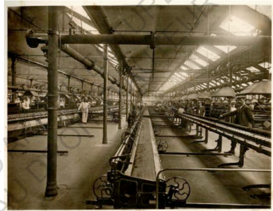
Figure 151 : Vue de la salle des métiers à filer (AM de Châteauroux, coll. 64S14)
