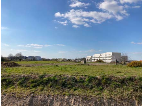
Figure 109 : Vue des logements en construction faisant partie de la phase 7 du projet
