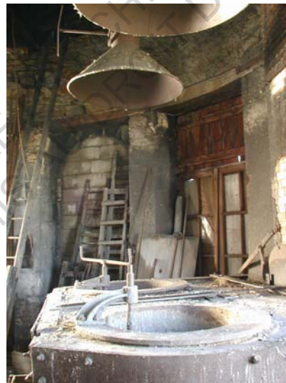
Figure 377 : Vue des cuves de la Tour à plomb
