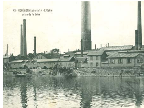
Figure 191 : Vue de l'usine Pontgibaud depuis la Loire, XXème siècle (AM de Couëron, 6Fi7)
