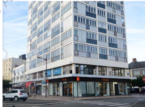
Figure 11 : Vue de la Tour St Cyran
