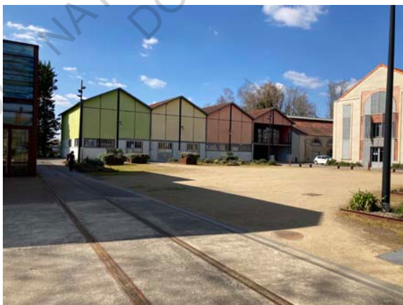
Figure 211 : Vue des locaux associatifs et des espaces de stockage
