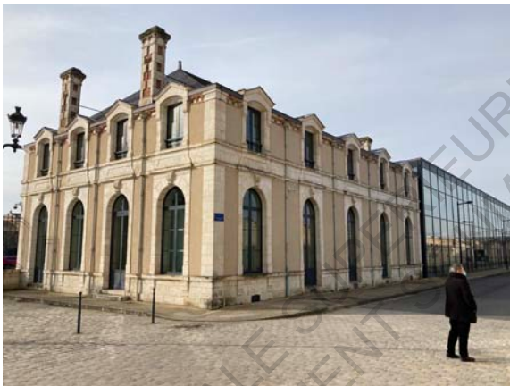
Figure 245 : Vue extérieure Nord de l'école HEI
