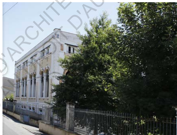
Figure 30 : Vue de l'usine électrique réhabilitée au XXIème siècle
