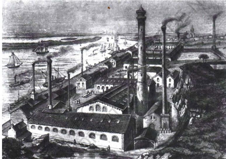
Figure 186 : Vue de l'usine Pontgibaud vers 1880 (AM de Couëron)
