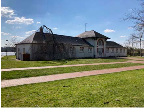
Figure 88 : Vue des Bains Douches et Lavoirs de Couëron
