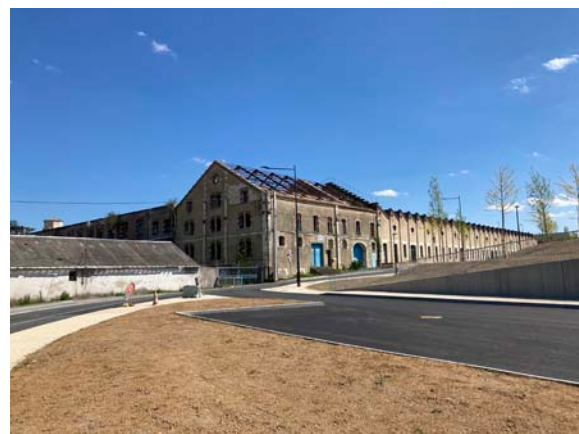
Figure 374 : Vue du bâtiment du Flockage et de l'Aile Ouest de l'usine Balsan
