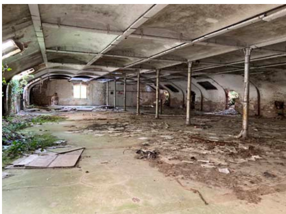
Figure 318 : Vue du niveau supérieur de l'ancien magasin de draps
