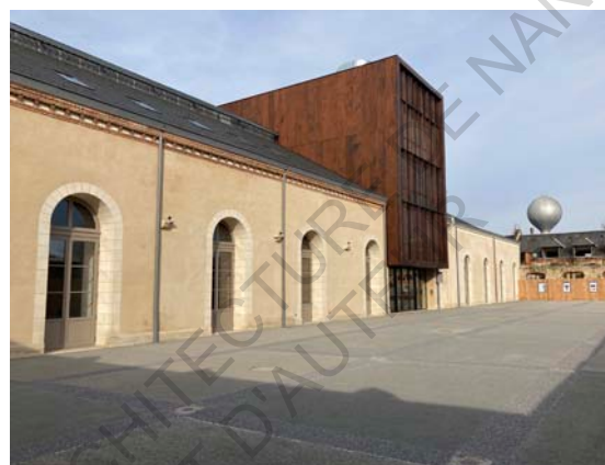
Figure 176 : Vue Est de la Cité du Numérique
