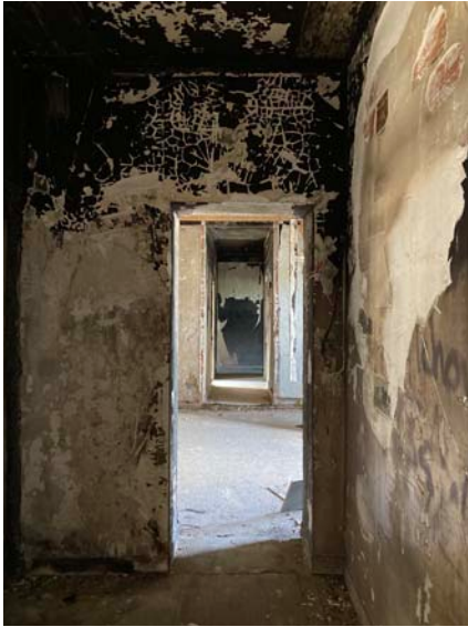
Figure 334 : Vue des espaces d'un ancien logements dans l'Aile des Tisserands
