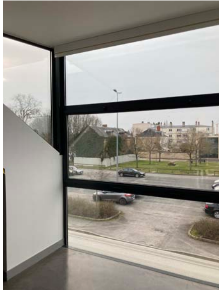
Figure 249 : Vue du décroché créé sur le toit
