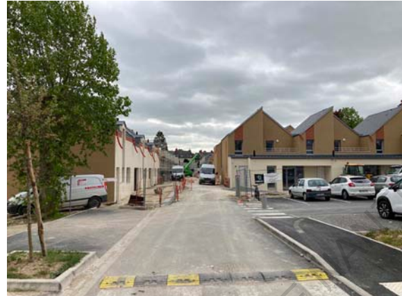
Figure 121 : Vue du chantier des 100 000 Chemises
