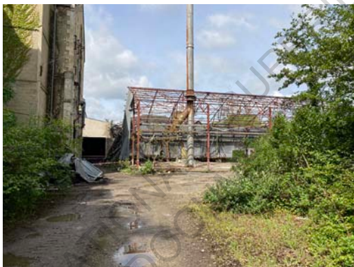
Figure 307 : Vue des travaux de démolition
