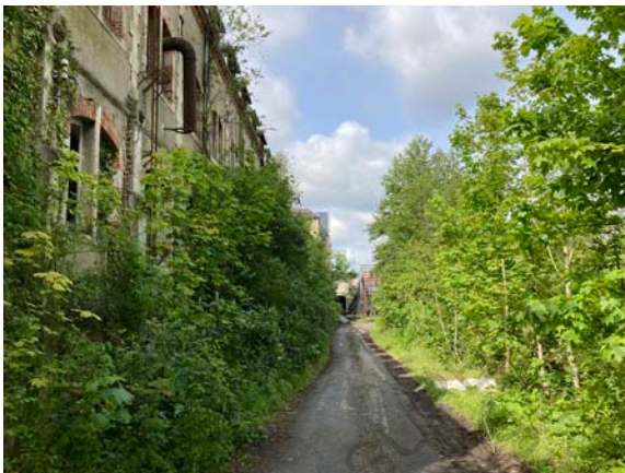
Figure 369 : Vue du Nord de l'usine Balsan donnant sur l'Indre à droite de la photo
