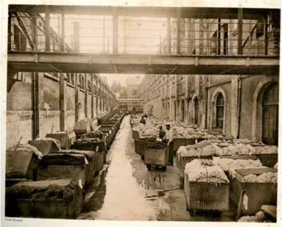
Figure 146 : Vue de la rue haute de l'usine Balsan (AM de Châteauroux, coll. 64S14)
