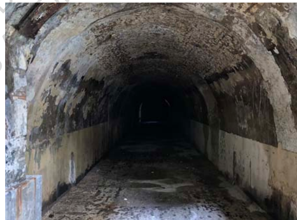
Figure 297 : Vue des caves de l'usine Balsan
