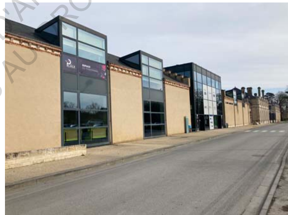
Figure 246 : Vue extérieure Sud de l'école HEI
