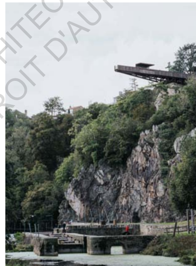
Figure 75 : Vue du Porte Vue de Château Thébaud
