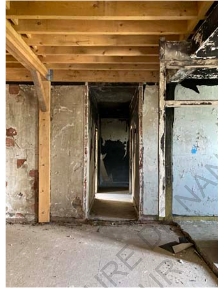
Figure 335 : Vue de la rénovation des planchers incendiés
