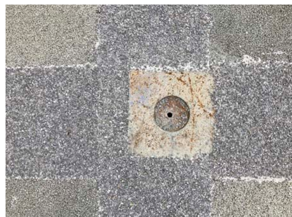
Figure 261 : Trace de poteau en fonte sur la place Est de l'usine
