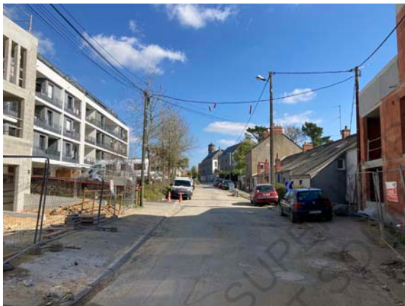
Figure 101 : Vue de la rue du Docteur Janvier, entre maisons existantes et nouveaux immeubles
