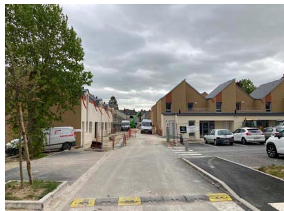
Figure 47 : Vue du chantier de construction de maisons sur le site des 100 000 chemises
