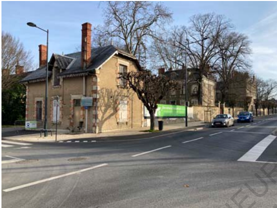
Figure 325 : Vue du pavillon du concierge et des maisons de cadres depuis l'avenue François Mitterrand
