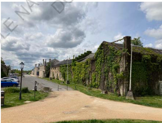
Figure 49 : Vue de l'Aile Est de l'usine Balsan restée en friche
