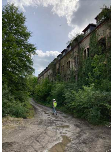
Figure 306 : Vue Est de la façade Nord du Flockage
