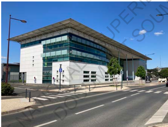
Figure 160 : Vue Sud Est de l'IUT de l'Indre
