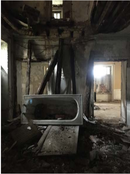
Figure 329 : Vue intérieure de la Maison Varaigne depuis un espace de passage
