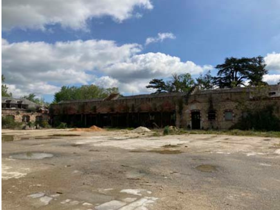
Figure 314 : Vue extérieure du bâtiment intermédiaire de l'usine Balsan
