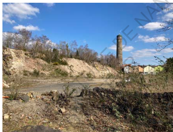
Figure 398 : Vue Est de la ZAC Rives de Loire
