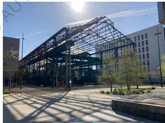
Figure 84 : Vue des Halles des Fonderies
