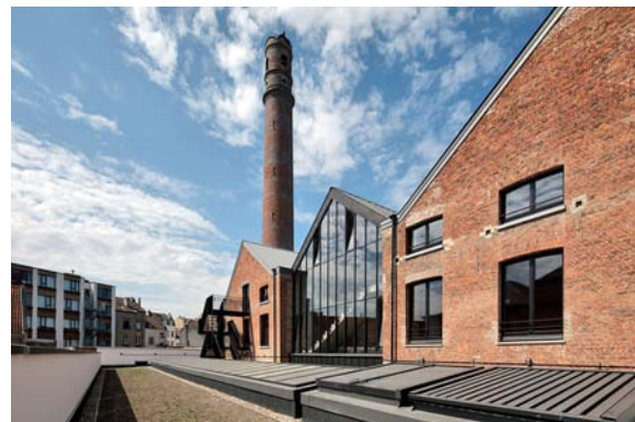
Figure 382 : Vue du Centre de la Tour à plomb
