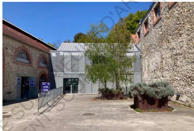
Figure 259 : Vue de l'extension créée pour relier l'espace musical et les locaux associatifs
