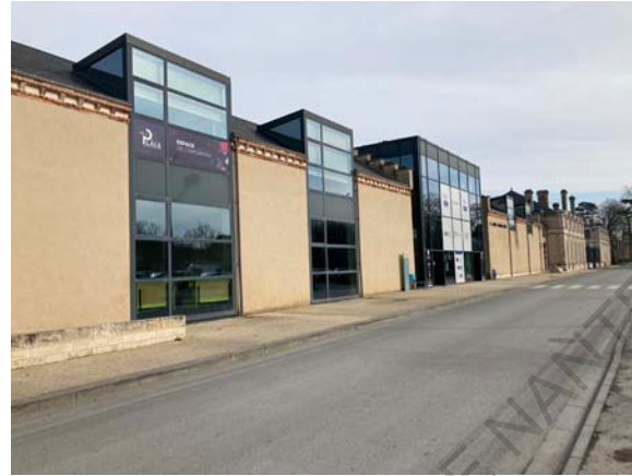
Figure 171 : Vue extérieure Sud de l'école HEI
