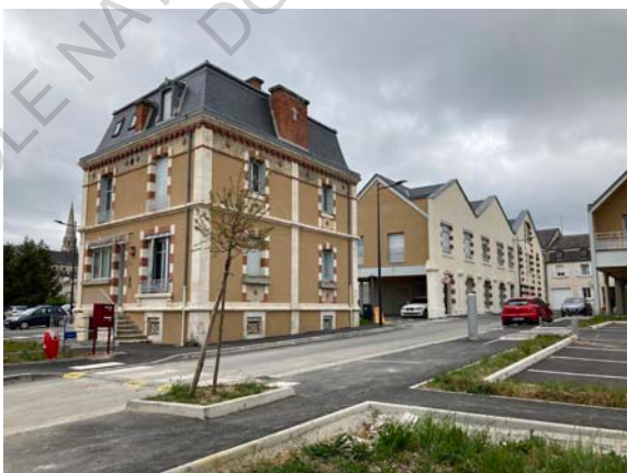
Figure 46 : Vue des bâtiments réhabilités de l'usine des 100 000 chemises
