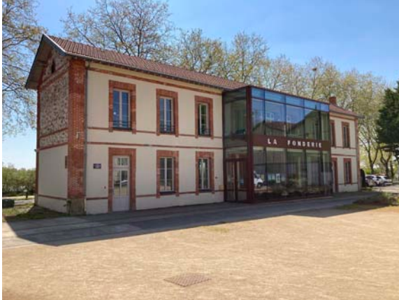
Figure 225 : Vue de la Fonderie depuis le quai Jean-Pierre Fougerat
