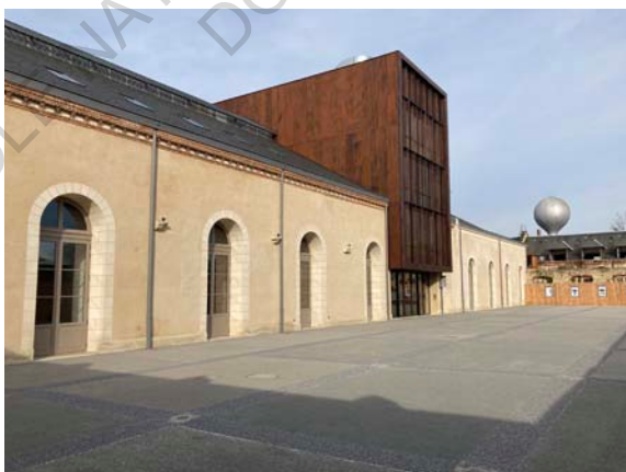
Figure 251 : Vue du Bâtiment de l'Horloge depuis le Carreau Ouest
