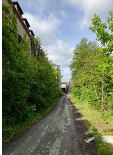
Figure 305 : Vue Ouest de la façade Nord du Flockage
