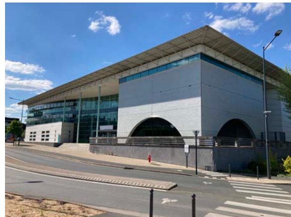
Figure 161 : Vue Sud Ouest de l'IUT de l'Indre
