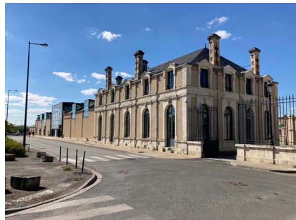
Figure 50 : Vue de l'Aile Ouest de l'usine Balsan, réhabilitée en école d'ingénieur HEI
