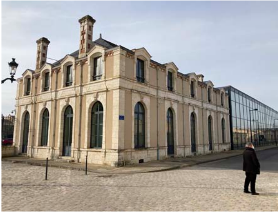
Figure 170 : Vue extérieure Nord de l'école HEI
