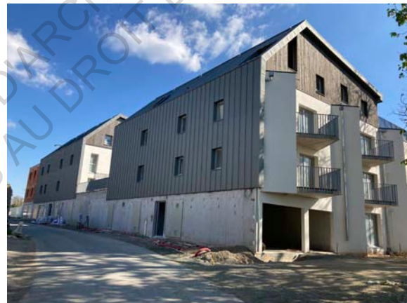
Figure 102 : Vue des nouveaux immeubles construits
