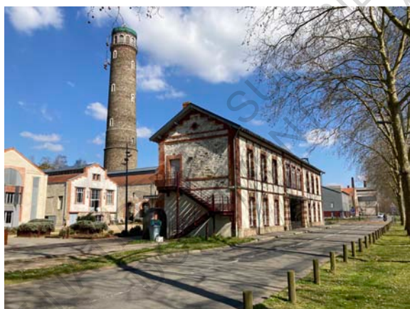
Figure 130 : Vue de l'usine Tréfinmétaux réhabilitée depuis le quai Jean-Pierre Fougerat
