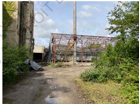
Figure 370 : Vue des démolitions de hangars en cours au Nord de l'usine Balsan et sur l'île du Flockage
