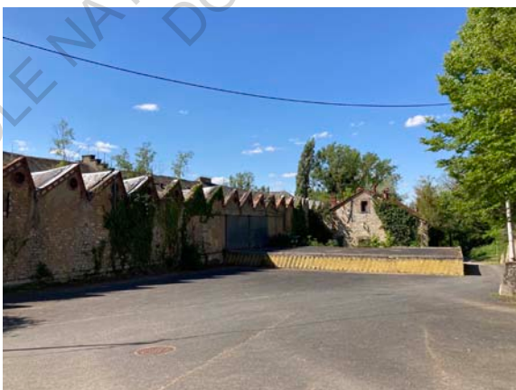
Figure 363 : Vue de l'Aile Est depuis le Parc Balsan
