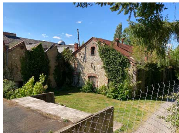
Figure 364 : Vue du hangar de l'Aile Est bloquant le passage
