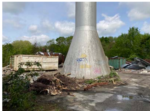
Figure 308 : Vue de l'île du Flockage en chantier
