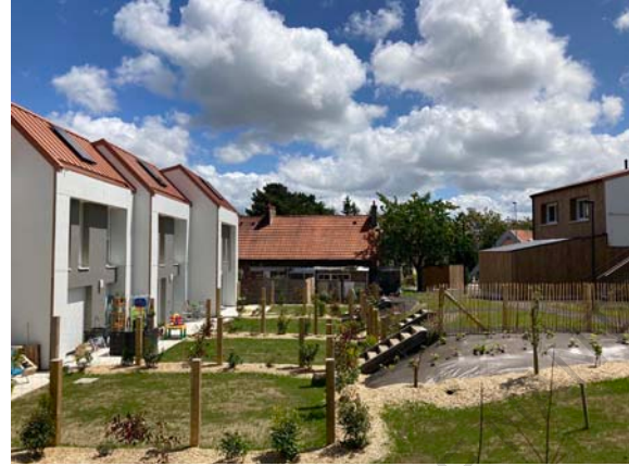
Figure 94 : Vue des nouvelles maisons en construction
