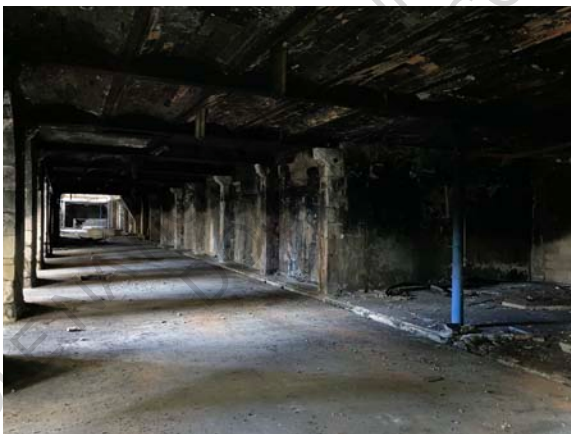
Figure 303 : Vue des espaces du R-1 du Flockage
