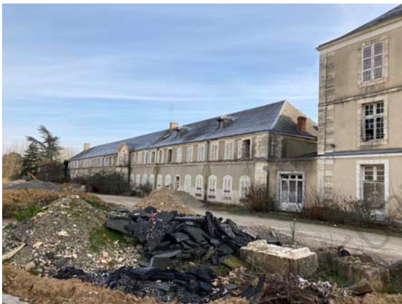
Figure 332 : Vue de l'Aile des Tisserands depuis la Cour des ouvriers
