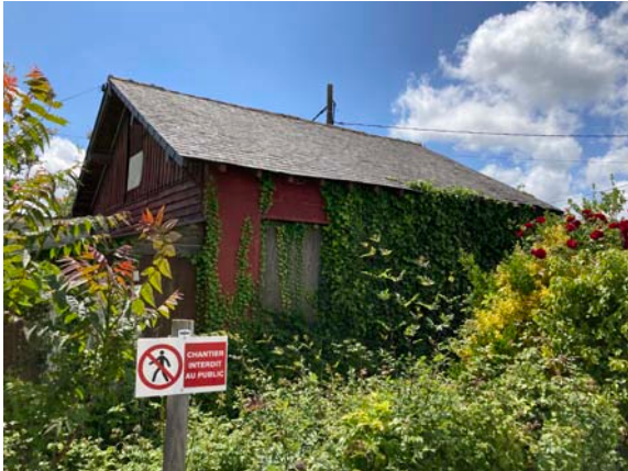
Figure 97 : Vue de la dernière maison ouvrière de la cité Bessonneau, en ruine
