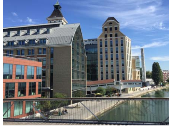
Figure 276 : Vue des Grands Moulins depuis la passerelle du Canal
