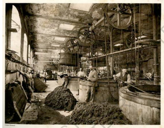
Figure 147 : Vue des ateliers d'écharnage de laine (AM de Châteauroux, coll. 64S14)
