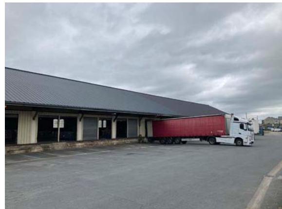
Figure 34 : Vue rapprochée des espaces de chargement de la SERNAM
