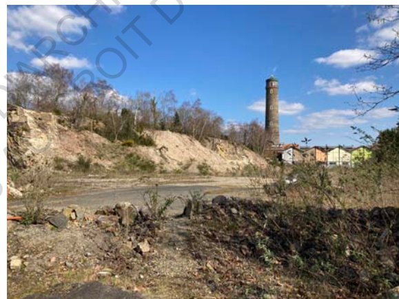
Figure 387 : Vue Est de la ZAC Rives de Loire
