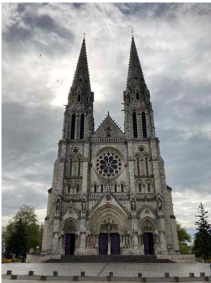
Figure 13 : Vue extérieure de l'église St André
