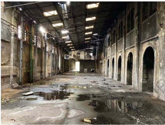
Figure 301 : vue Ouest de la rue basse
