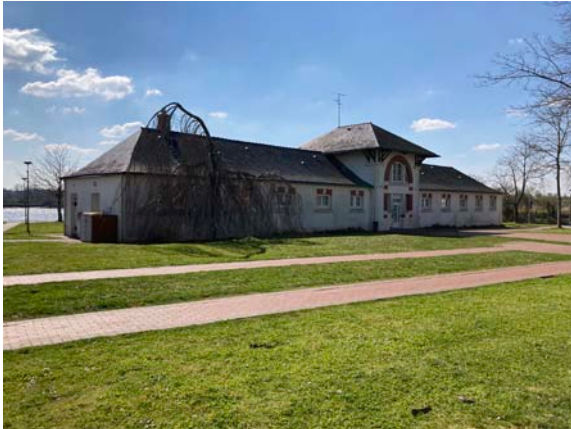
Figure 134 : Vue des Bains Douches et Lavoirs de Couëron
