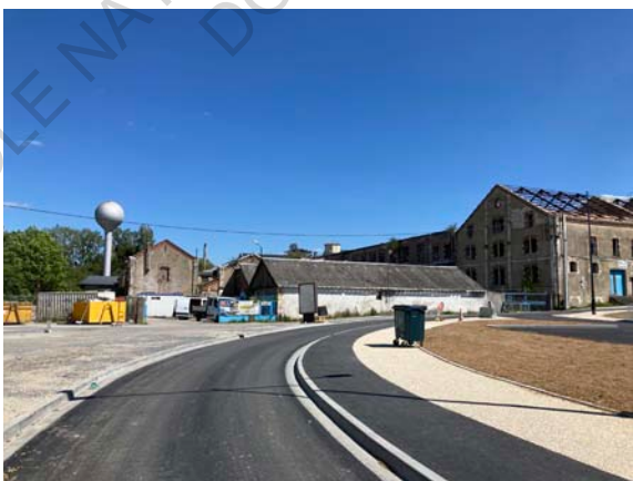
Figure 373 : Vue correspondant aux perspectives d'évolution du Nord du bâtiment du Flockage
