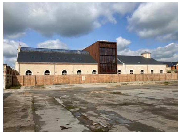
Figure 252 : Vue du Bâtiment de l'Horloge depuis le Carreau Est
