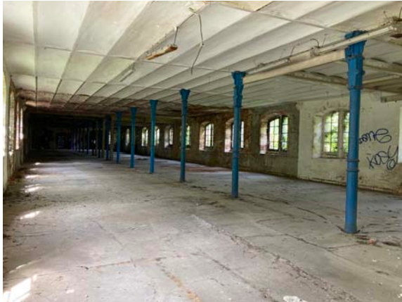
Figure 294 : Vue intérieure du RDC du Flockage dans une partie bien conservée
