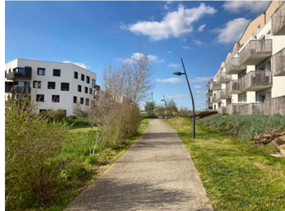
Figure 110 : Vue des logements construits faisant partie de la phase 6 du projet
