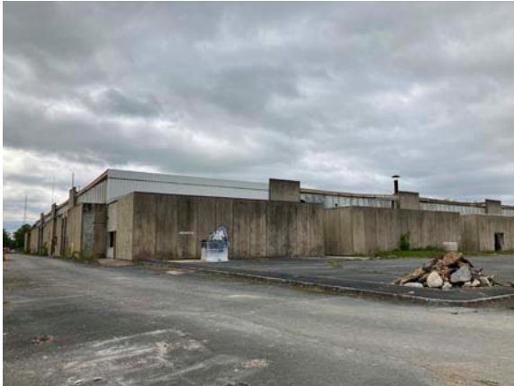
Figure 44 : Vue extérieure de l'usine Cerabati
