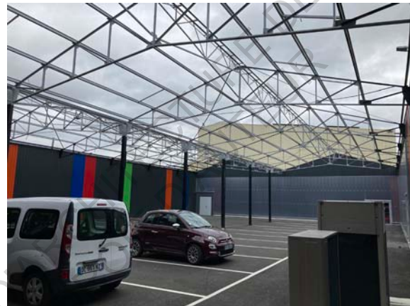
Figure 43 : Vue du parking du complexe et de la charpente métallique de l'usine Auga
