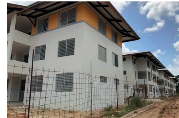
Chantier des logements sociaux de la ZAC Saint-Maurice, crédit : SEMSAMAR, 2019
