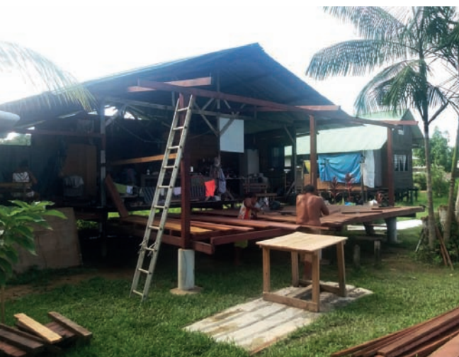
Chantier du carbet de Jeff et Sol, crédit : Jeff, 2020
