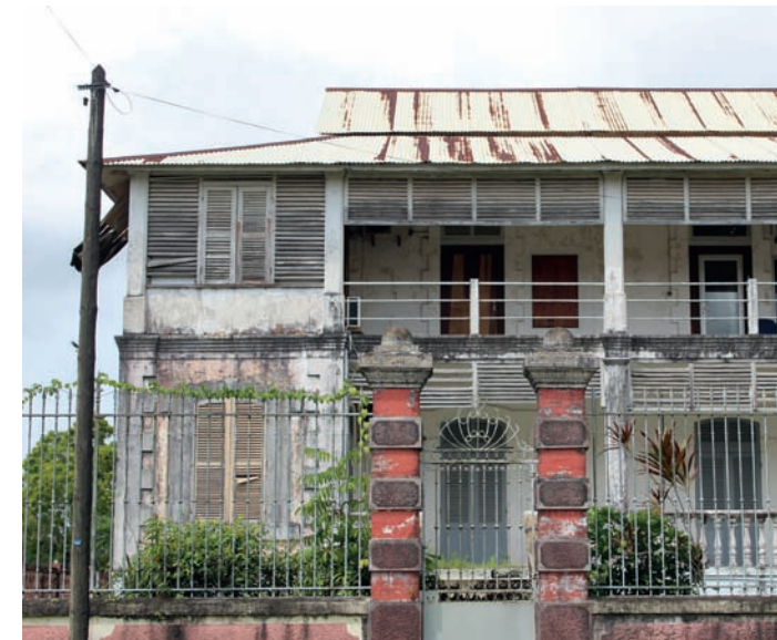
Bâtiment classé de l'ancien hôpital André Bouron, construit dans les années 1890, crédit : Maëlle Grouet, 2018
