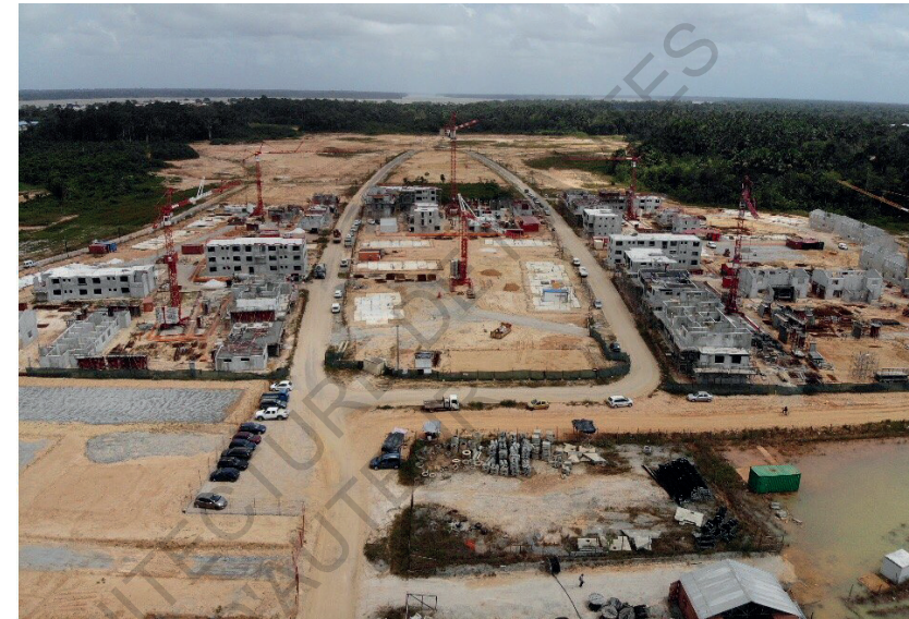
Chantier de la ZAC Saint-Maurice, crédit : SEMSAMAR, 2018
