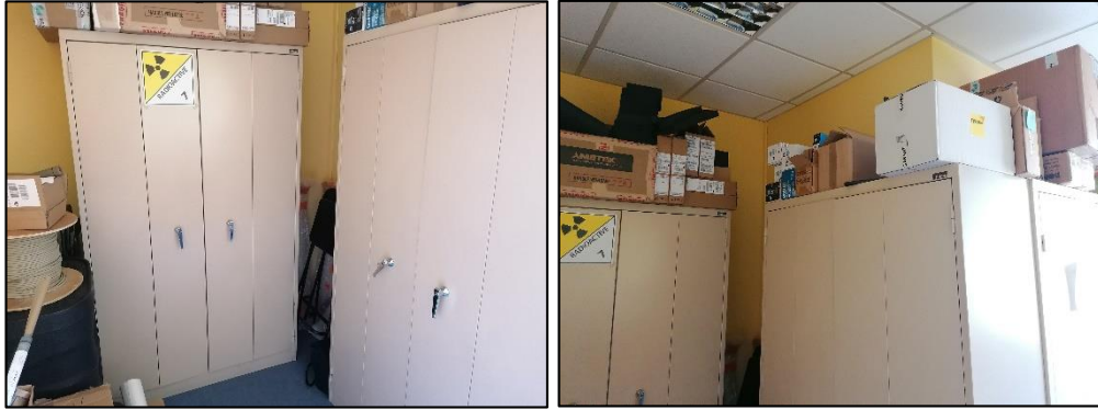
Figure 11 : Aperçu de l'encombrement disposé dans la pièce
