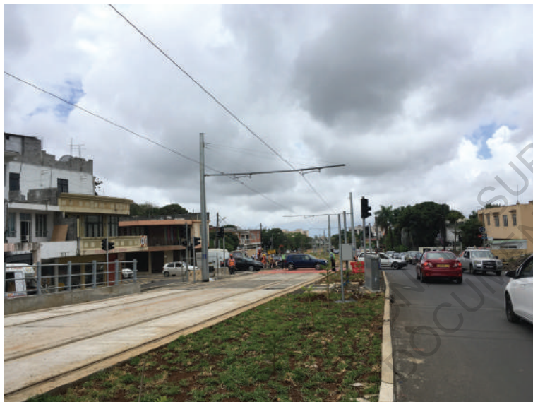
La Rue Vandermeersch : d'une ligne surélevée à des rails au niveau de la route (Photos prises le 23 novembre 2019)
