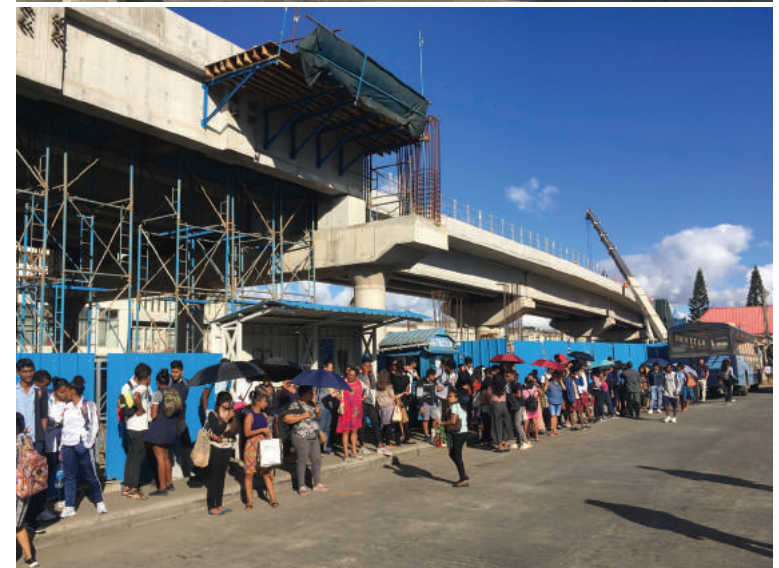
Construction d'une gare multimodale avec une plateforme surélevée pour le métro et espace d'attente restreint (Photos prises le 5 juillet 2019)
