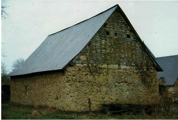
Fig.131 - Bâtiment entièrement réalisé en terre pour la structure porteuse du rez-de-chaussé, et en remplissage entre colombage pour le pignon d'étage - Simplé (53).
