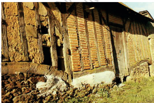
Fig.139 - Terre crue et terre cuite : Soubassement pierre et colombage avec remplissage torchis sur barreaux et enduits et grandes briques plates.
