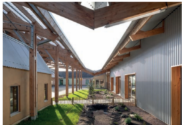
Fig.125 - École élémentaire et restaurant scolaire en structure bois et terre crue (torchis) à Baudon (35), par le Collectif FARO.
