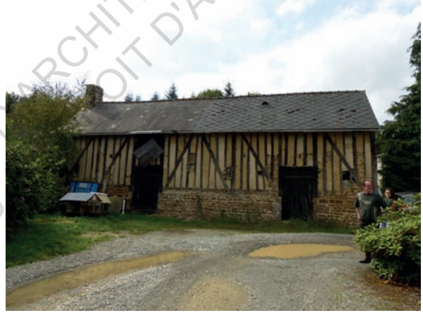
Fig.146 - Grange en pan de bois et terre crue sur soubassement en pierre au lieu-dit de La Petite Basse Cour, à Rennes-en-Grenouille (53).
