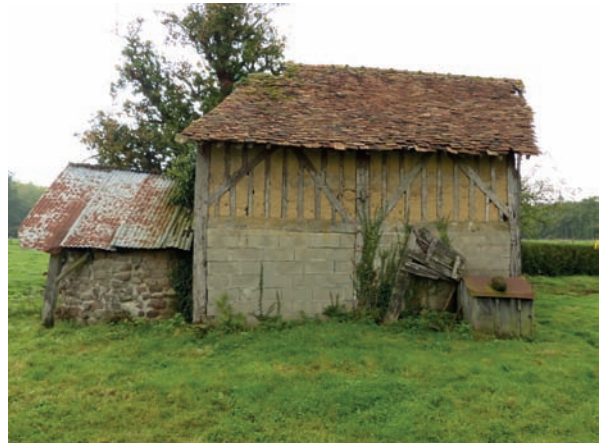
Fig.148 - Remise en pan de bois et terre crue sur soubassement en parpaing au lieu-dit de La Forge, à Rennes-en-Grenouille (53).
