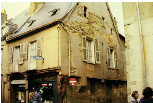
Fig.136 - Maison à colombages sur rez-de-chaussée en pierre. Les étages sont dissimulés par des enduits sur lattis, posés aux siècles précédents pour prévenir les risques d'incendie, à l'intérieur cloisons en torchis - Laval (53).
