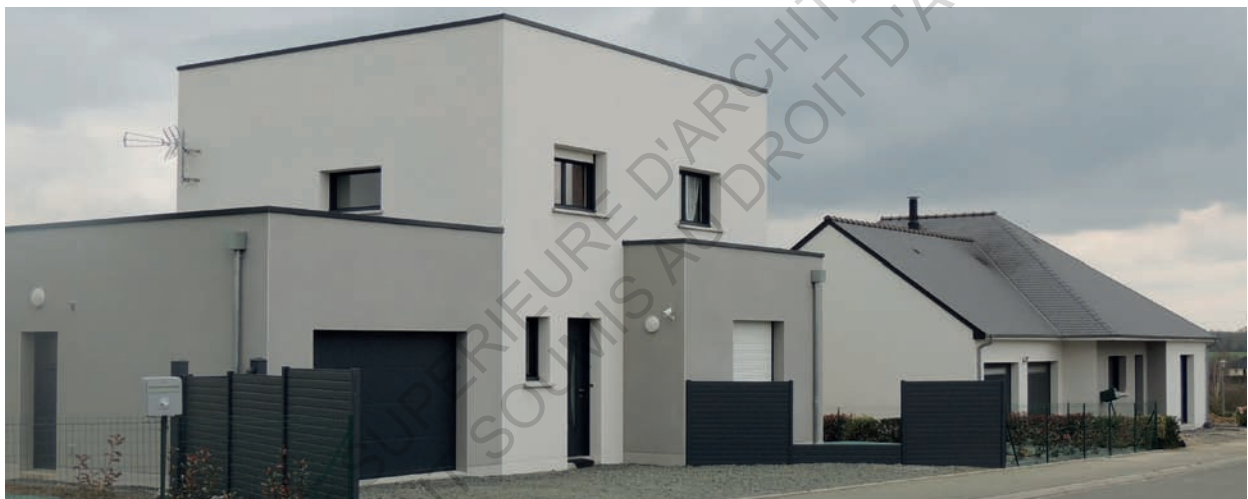
Fig.49 - Les maisons «parpaing» du lotissement.
