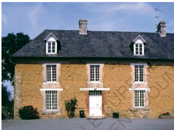
Fig.169 - Maison traditionnelle normande construite en bauge, photographie de Pascal Corbierre.
