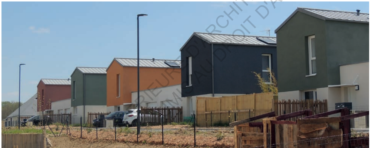
Fig.82 - Les maisons «parpaing» du lotissement.
