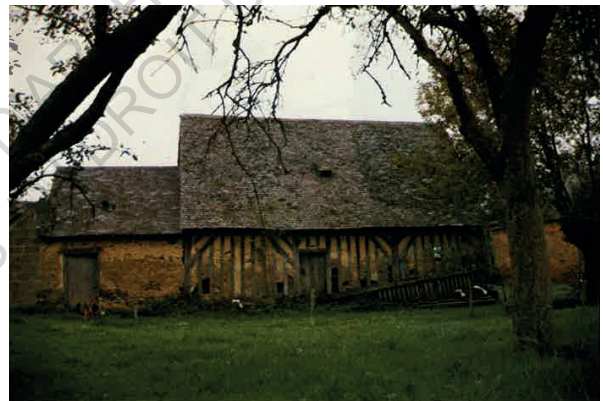
Fig.134 - Assemblage de maçonnerie de terre et d'assises en schiste ardoisier, sur soubassement et chaîne d'angle en ardoise - Région de Renazé (53).
