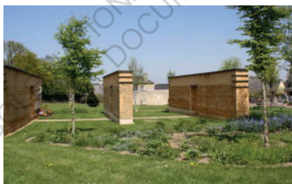
Fig.174 - Extension du cimetière d'Audrieu dans le Calvados (14), réalisation de trois murs en pisé, photographies DVN architectes.
