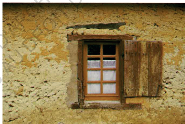
Fig.138 - Détail du mur et de l'ossature d'une baie d'une maison d'habitation réalisée entièrement en mottes d'argiles posées sur des lits horizontaux avec interposition d'une couche de genêt et d'ajonc - Loigné (53).
