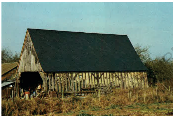
Fig.137 - Grange dont les murs bas sont réalisés en colombage et remplissage torchis sur barreaux. Les figures en planches - St-Denis-du-Maine (53).
