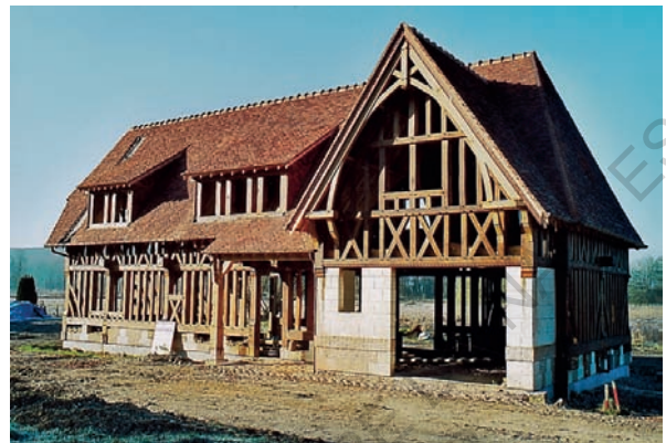
Fig.168 - Squelette des murs en pan de bois d'une maison traditionnelle normande, photographie d'Alexandre Vernon.
