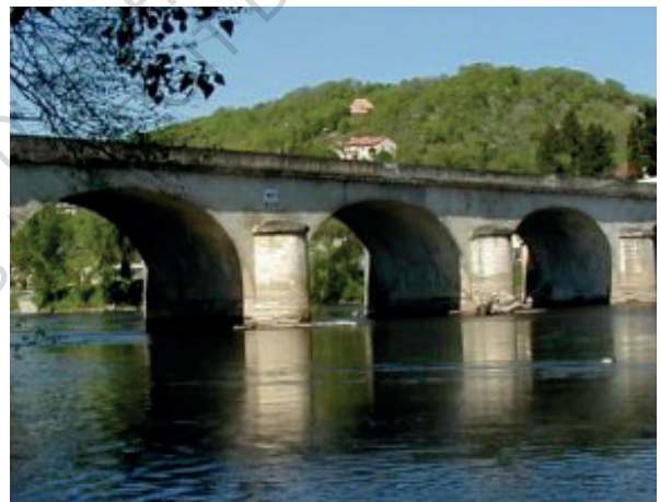
Fig.2 - Pont de Louis Vicat à Souillac, Jacques Mossot.
