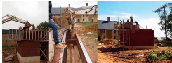
Fig.185 - Maison prototype du projet CobBauge, conception Raphaël Rattier (ENSA Normandie). Réalisation de murs en bauge, coffrés et compactés, avec capteurs afin de mesurer les capacités thermique de la construction et décrire, par la suite, les avancées scientifiques quant aux objectifs initiaux du projet. Photographies François Steiff.
