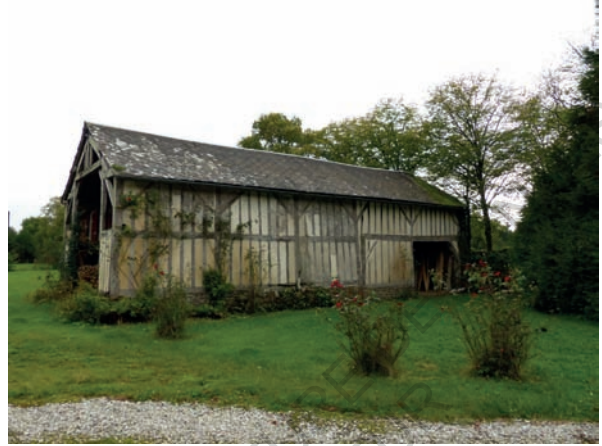
Fig.144 - Grange en pan de bois et terre crue sur soubassement en pierre dans le Bois du Maine, à Rennes-en-Grenouille (53).
