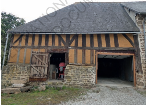
Fig.147 - Garage en pan de bois et terre crue sur soubassement en pierre dans le bourg de Rennes-en-Grenouille (53).
