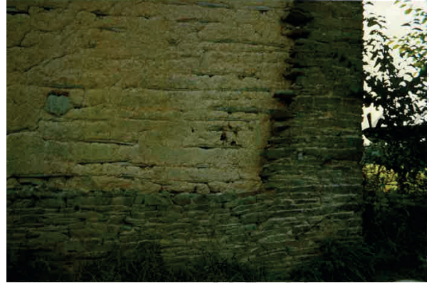
Fig.132 - Assemblage de maçonnerie de terre et d'assises en schiste ardoisier, sur soubassement et chaîne d'angle en ardoise - Région de Renazé (53).
