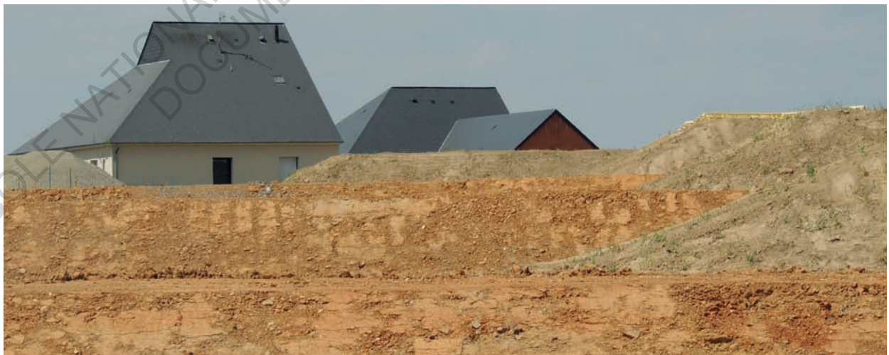
Fig.83 - Le «tas de terre» du lotissement du «Domaine de la Castanea».
