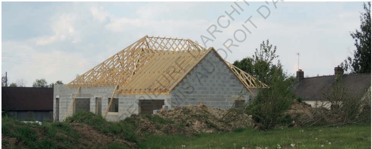
Fig.60 - Les maisons «parpaing» du lotissement.
