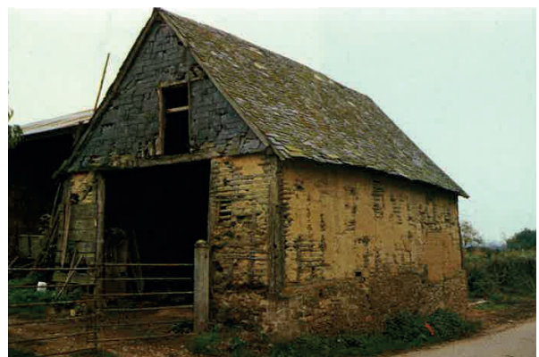
Fig.135 - Remise à matériel agricole à colombage à remplissage et enduit d'argile - Houssay (53).
