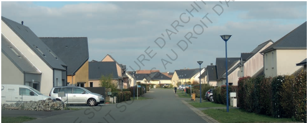
Fig.38 - Les maisons «parpaing» du lotissement.
