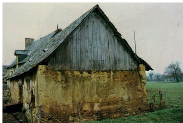
Fig.140 - Maison très ancienne, abandonnée, construite en terre, sur soubassement en pierre, pignon en larges planches de châtaignier - Peuton (53).
