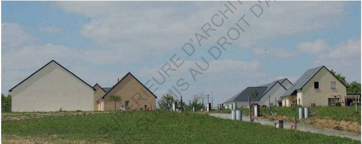
Fig.71 - Les maisons «parpaing» du lotissement.
