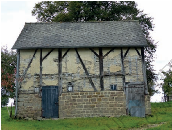
Fig.145 - Construction en pan de bois avec remplissage et enduit en terre crue sur soubassement en pierre au lieu-dit de La Maillardière, à Rennes-en-Grenouille (53).
