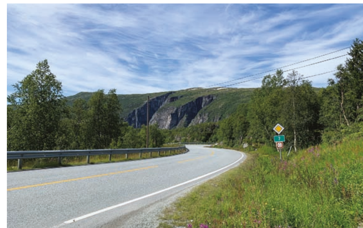
Fig. 56. La route d'accès aux belvédères, Vøringsfossen.
