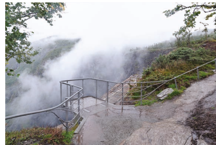
Fig. 40. Belvédères conçus à l'échelle 1:1, Vøringsfossen.
