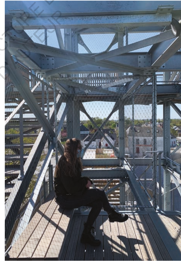
Fig. 32. Cadrages à travers la structure en acier.
