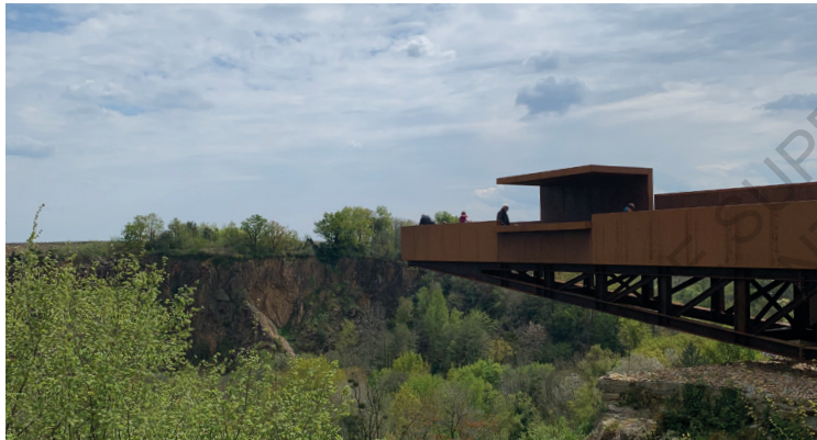
Fig. 26. (en haut) L'avancée dans le vide. Fig. 27. (en bas) La structure en porte-à-faux.
