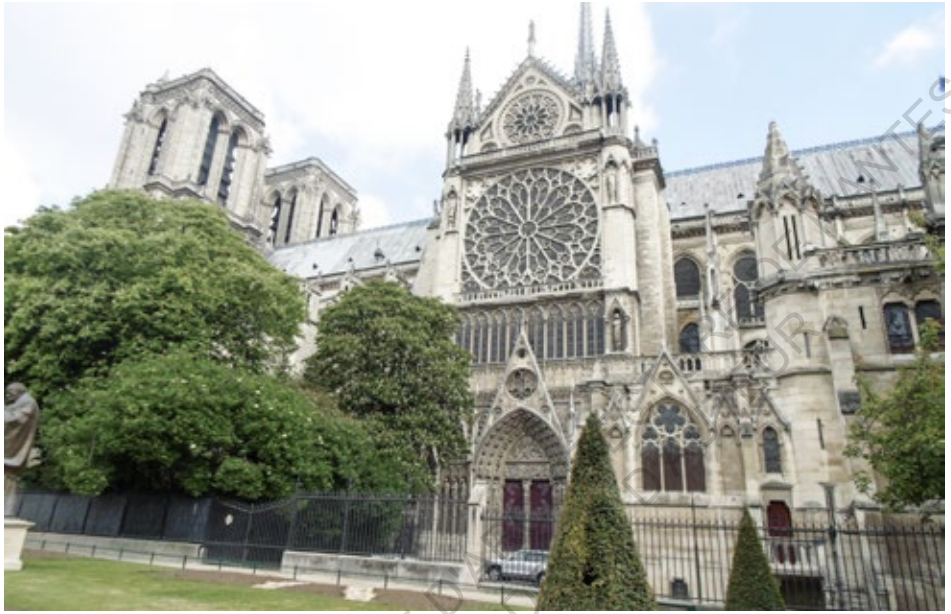
Fig. 23 : Photographies de Notre-Dame, avril 2018, façade Nord
