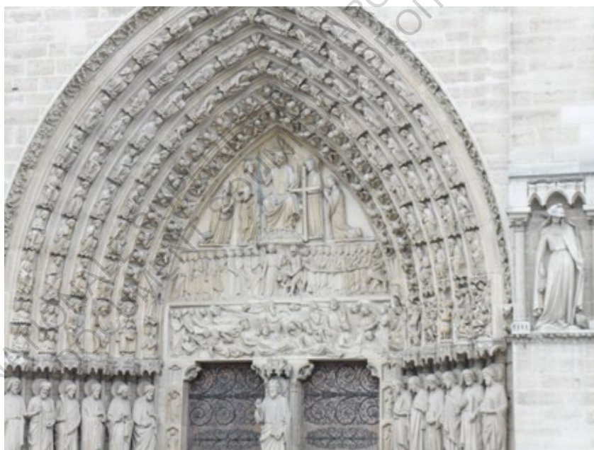
Fig. 25 : Photographies de Notre-Dame, avril 2018, Portail principal, Façade Sud
