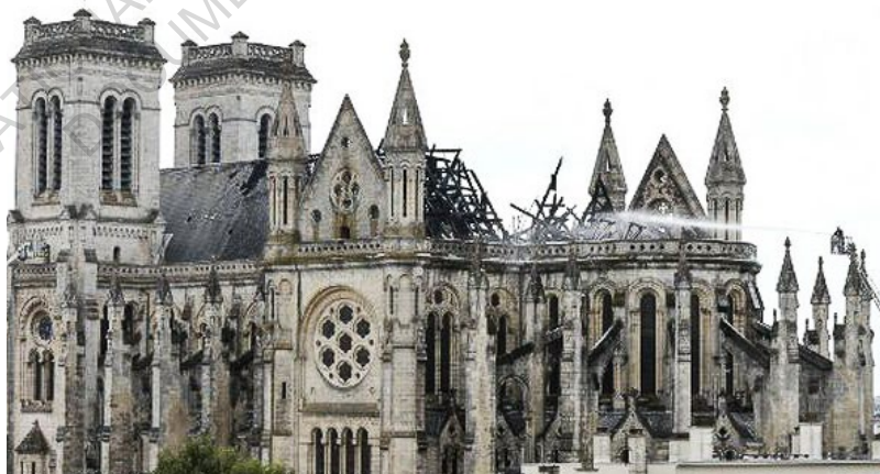
Fig. 40 : Photographies d'après le sinistre de la basilique
