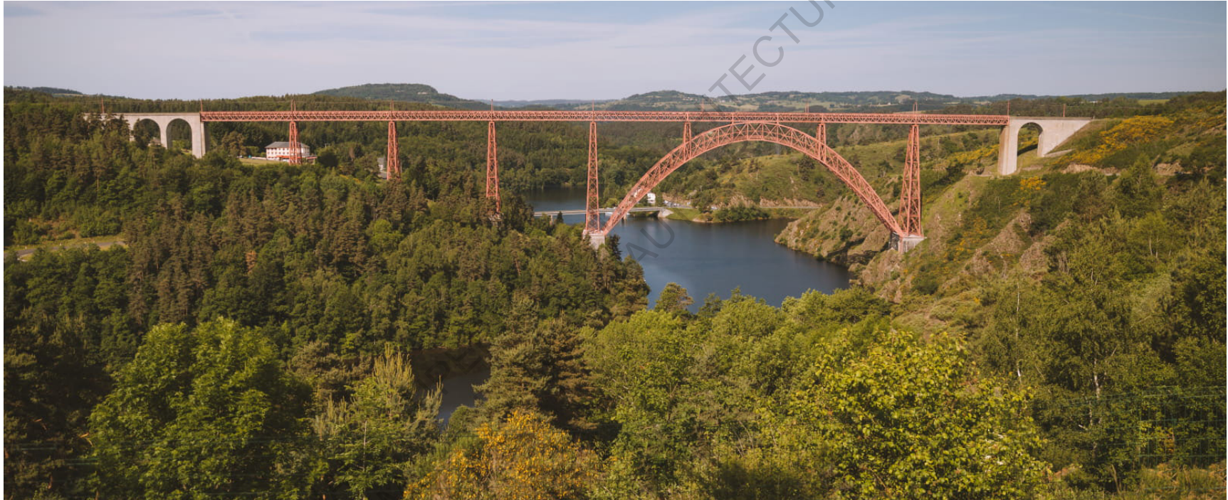
Le viaduc de Garabit, conçu par l'ingénieur Léon Boyer et réalisé par Gustave Eiffel, classé monument historique en 2017
