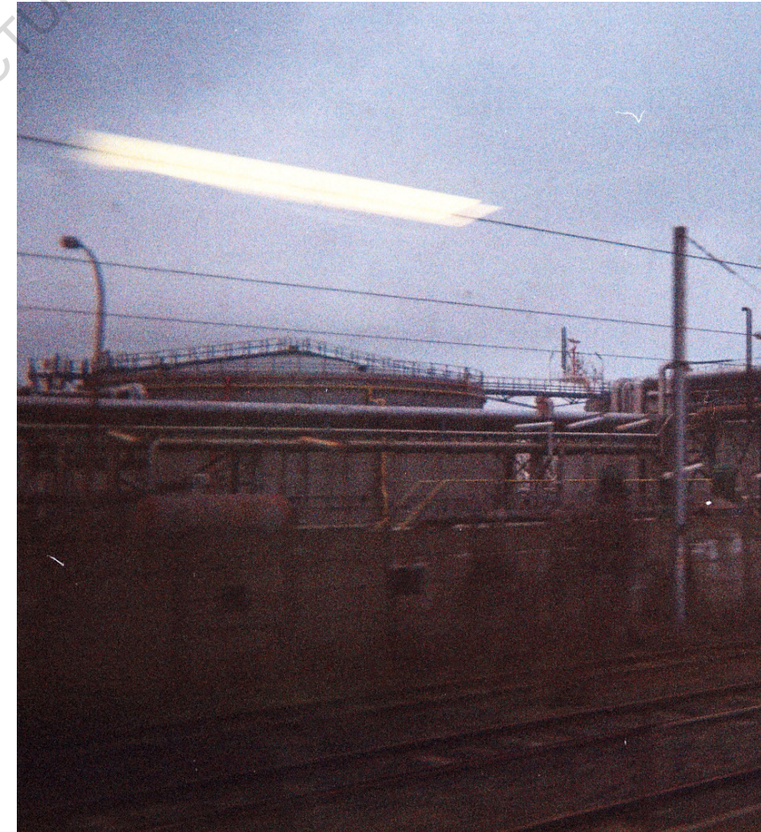
Saint-Nazaire - Nantes_février 2021 Raffinerie de Donges vue du TGV
