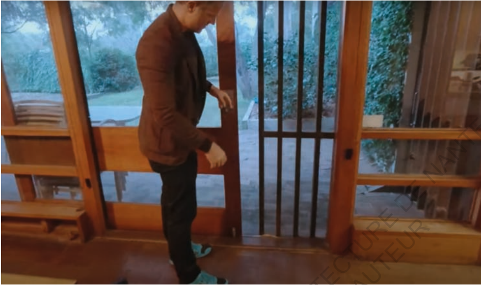
Fig. 39 : Barreaux de sécurité intégrés dans la trame structurelle, AIA HQ, Canberra, Australie ©Archimarathon
