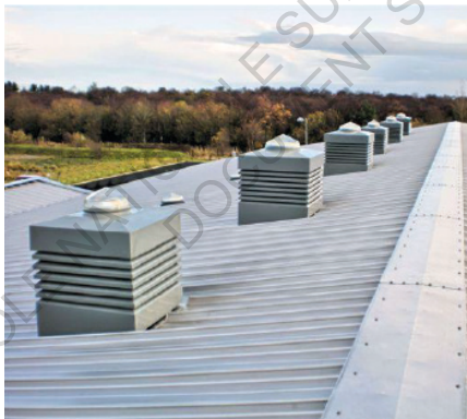
Fig. 34 : Tourelles à vent (gauche) et simulation des débits d'air (droite) ©TRIBU
