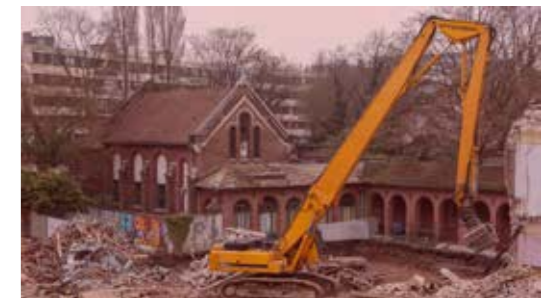
12 Chantier de démolition du foyer L'Oasis et de la chapelle Saint-Joseph du XIXème siècle, rue Colson à Lille. https://www.nordeclair.fr/918393/article/2021-01-09/roubaix-l-etonnant-destin-d-une-chapelle-du-xixe-siecle-demolie-aussi-vite-qu
