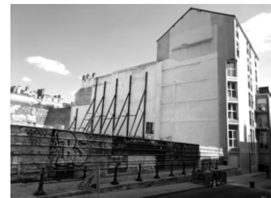
13 Dent creuse en chantier sur le site de l'ancien hôtel de la Duchesse Anne, rue Henri IV à Nantes, photographie de l'auteur, avril 2021.
