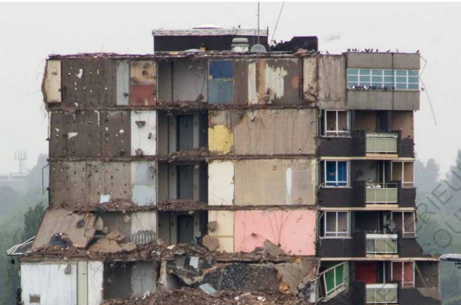
11 Démolition d'un immeuble à Walsall, au Royaume-Uni, © Richard, août 2008. https://www.flickr.com/photos/rjt208/albums/72157601242197129
