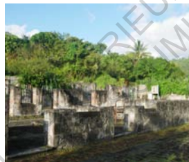
Ruines de la maison coloniale de santé Classées en 1996
