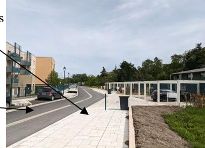
Figure n° 32 : vue sur la route la plus proche de la rivière et le trottoir blanc surélevés à 80 et 100 cm au-dessus des PHEC
