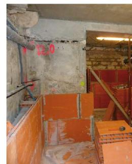
Figure n° 23 : mise en place de la paroi respirante au sous-sol
