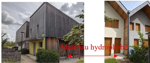
Figure n° 22 : bâtiments surélevés avec un matériau hydrophobe
