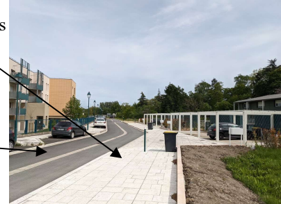
Figure n° 32 : vue sur la route la plus proche de la rivière et le trottoir blanc surélevés à 80 et 100 cm au-dessus des PHEC Source : réalisation personnelle
