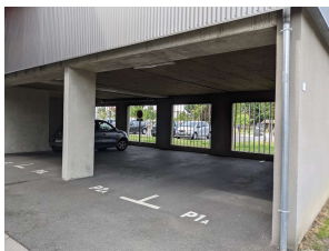
Figure n° 33 : parking transparent Source : réalisation personnelle
