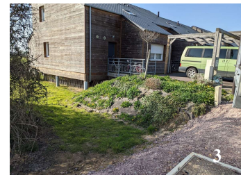
Figure n° 16 : vue sur le remblai utilisé pour surélever la route Source : réalisation personnelle
