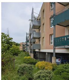
Figure n° 35 : parking transparent Source : réalisation personnelle
