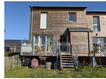
Figure n° 12 : réappropriation d'un espace sous-pilotis Source : réalisation personnelle
