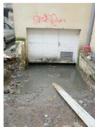
Inondation du sous-sol le 22/07/2013
