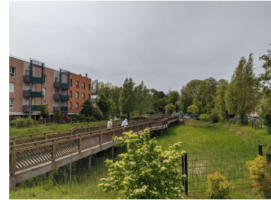
Figure n° 44 : autre vue sur le bassin de rétention d'eau du quartier Source : réalisation personnelle
