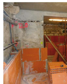
Figure n° 23 : mise en place de la paroi respirante au sous-sol Source : C.a.u.e.
