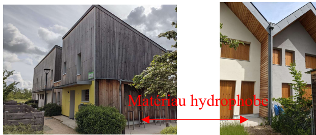
Figure n° 22 : bâtiments surélevés avec un matériau hydrophobe Source : réalisation personnelle
