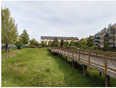
Figure n° 454 : vue sur le bassin de rétention d'eau du quartier Source : réalisation personnelle
