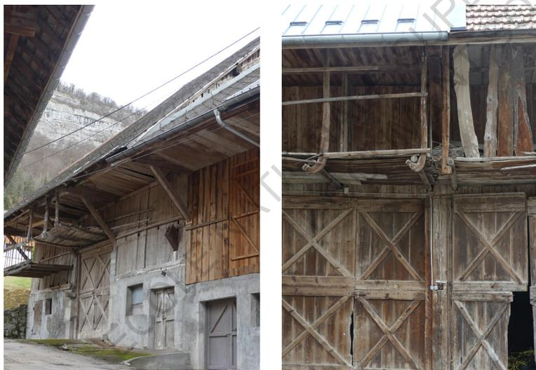
Dans le village certaines granges ont la particularité de posséder des tavalans. Il s'agit de troncs de sapins recourbés mis en œuvre pour soutenir des sortes de balcons suspendus aux avant-toits et servant à entreposer le foin. Aujourd'hui, leur usage tend à disparaître pour être réinvesti par un usage plus privatif lié à l'espace de la maison.
