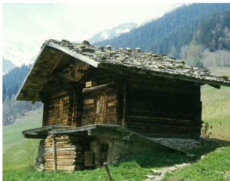
Grenier à Arêches Beaufort, Savoie © CAUE Savoie
