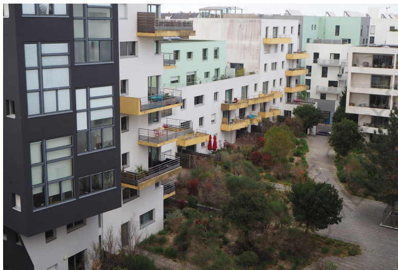
Esplanade commune au centre de l'îlot. photo personnelle.
