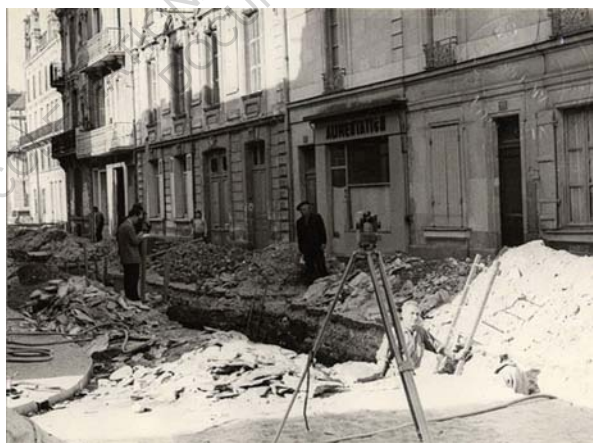
Fig.62 - Installation du tout à l'égout en 1965 rue de la Roë à Angers - angersloire.metropole.fr
