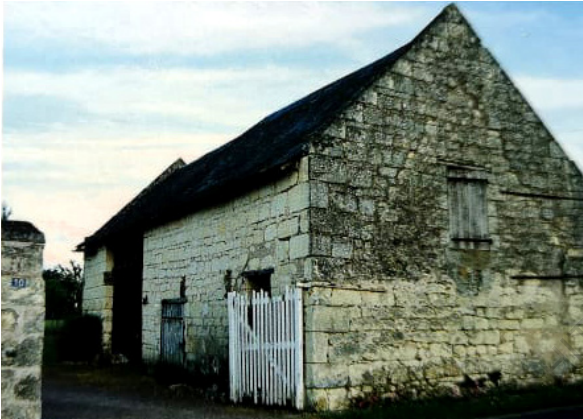
Fig.23 - Grange maraîchère faisant face à la maison d'habitation, Varennes-sur-Loire - La maison paysanne, histoire, guide de restauration, typologie région par région
