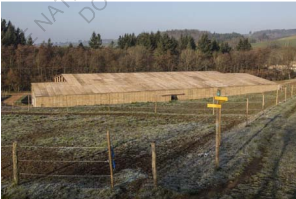
Fig. 20 - Centre équestre du Lac des Sapns, Cublize (69), Fabriques Architectures Paysages - fabriques-ap.net
