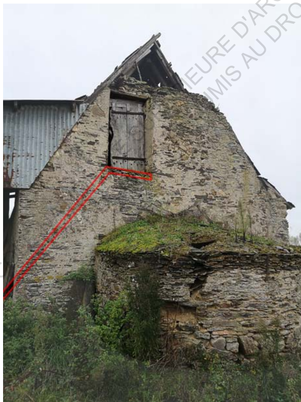
Fig.35 - Pignon Ouest d'un des bâtiments de la ferme de la Panière, aujourd'hui en ruine. La présence d'une porte au niveau du grenier laisse penser qu'un escalier en bois devait autrefois enjamber le four à pain - Photo personnelle
