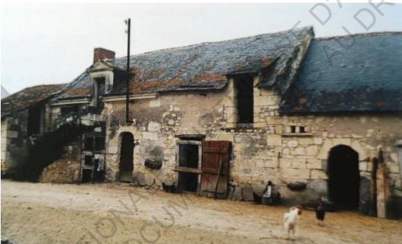
Fig.24 - Cour d'une ferme maraîchère du saumurois - La maison paysanne, histoire, guide de restauration, typologie région par région
