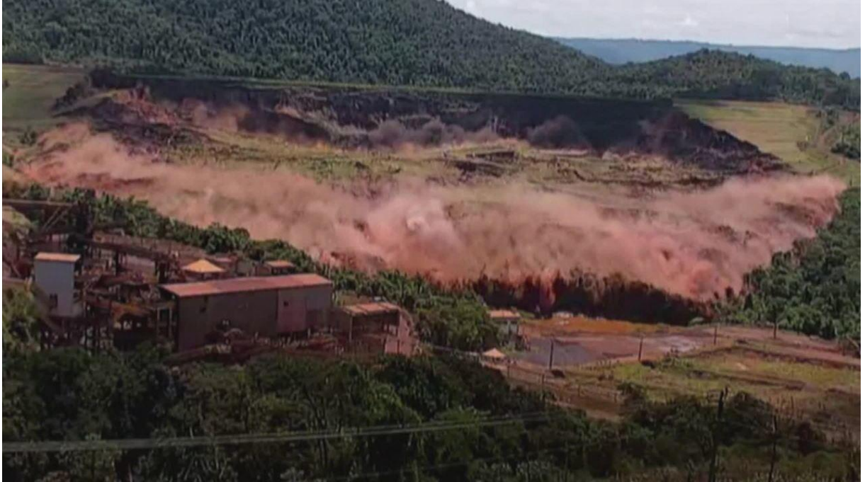
16. Brumadinho, rupture du barrage, 2019, Brésil. Caméra de vidéo surveillance, Vale S.A.
