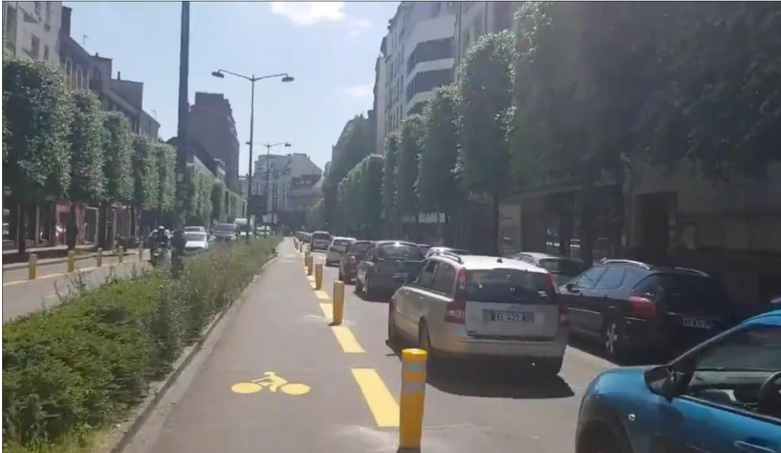
© Capture d'écran d'une vidéo Rennes Infos Travaux/Twitter/26 mai 2020
