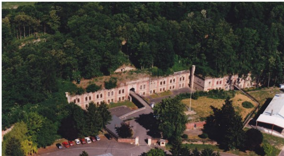
Photographie aérienne du « fort Kléber » ancien « fort "Fürst" Bismarck » situé à Wolfisheim en Alsace. Propriété de GHP, juin 1998.
