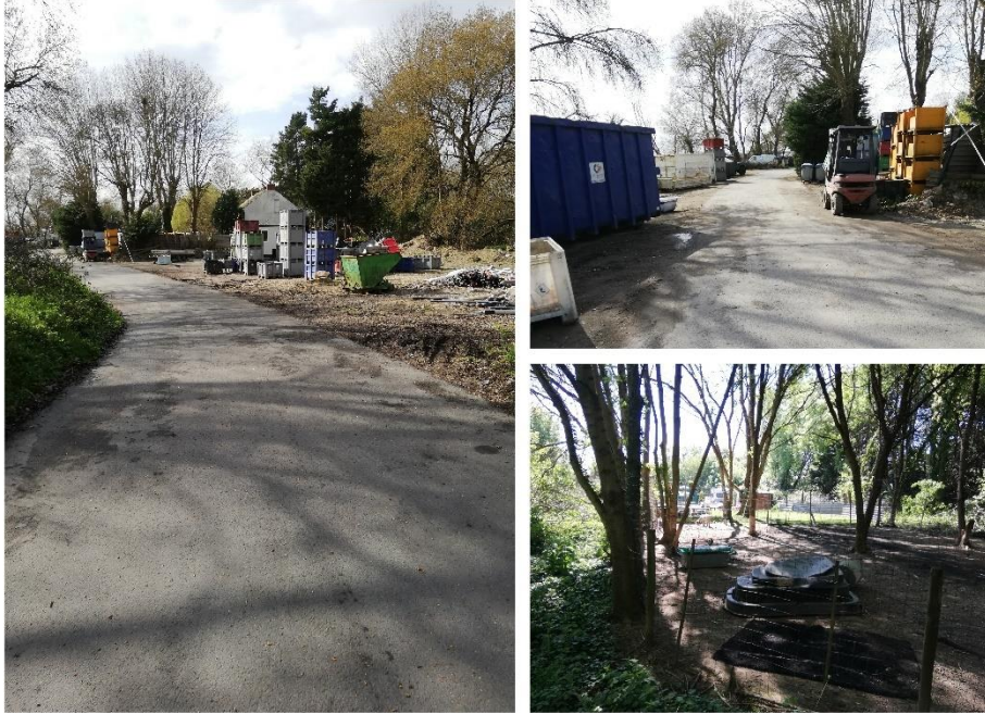
Une zone d'habitation de gens du voyage sédentarisés et des activités de ferrailage en expansion le long de la voie carrossable de la Loire à Vélo et vers les bois.
