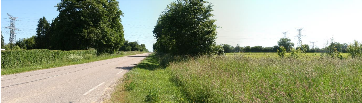
Figure 20 : Photographie de la double ligne THT depuis la Ferme de la Tournerie sur la D971, Mai 2021, Florian Collignon
