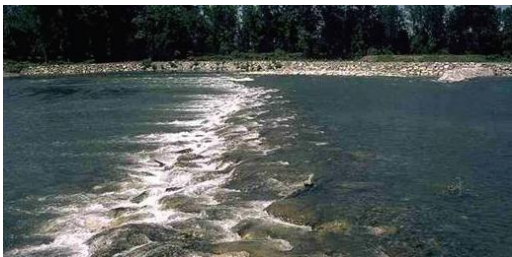
Seuil en enrochement de Lescar sur le Gave de Pau (64). (GHAAPPE, 2006)
