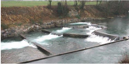
Pré-barrages Gurmençon (64) - rivière Gave d'Aspe. (GHAAPPE, 2006)
