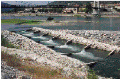
Passe à seuils successifs à échantrements triangulaires de Codolet (30) - rivière sur la Cèze. (Photo MRM)
