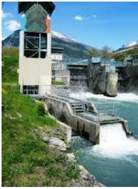
Passé à poisson et ascenseur de Montrigón (73) - rivière l'Isère. (Ouvrage classé)
