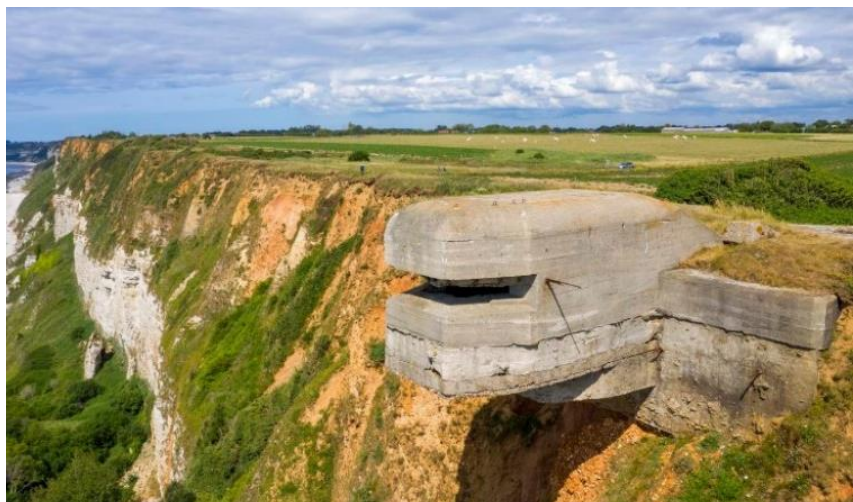
Figure 4 : Le bunker "suspendu" à Heuqueville (Guillaume Lefebvre, 2020)
