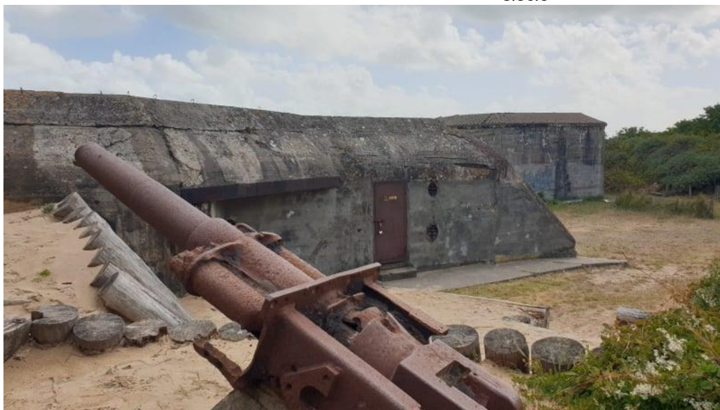
Poste d'observation de tir et casemate (camouflé par le toit en tuile)
