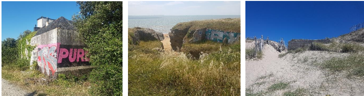
Figure 13 : Les bunkers abandonnés : dans le boisement en recul de la côte à Batz-sur-Mer, ruines sur la côte rocheuse de Pornic, bunkers dans les dunes de La Turballe (Koncz, 2021)
