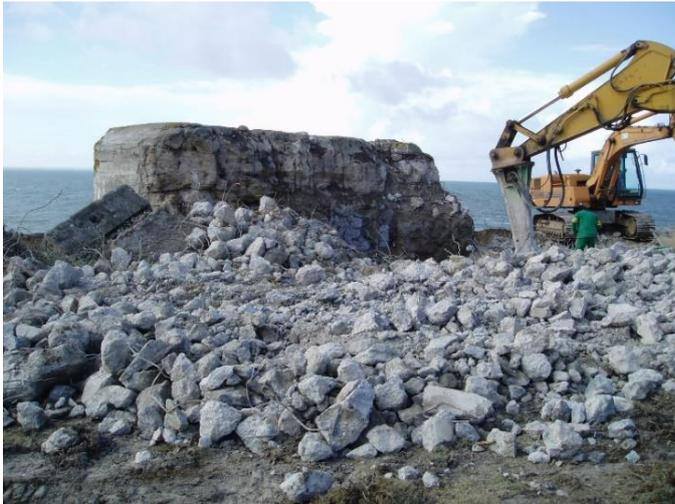
Figure 6 : La démolition d'un bunker à cause de son mauvais état à Pornic (Phytolab, 2003)
