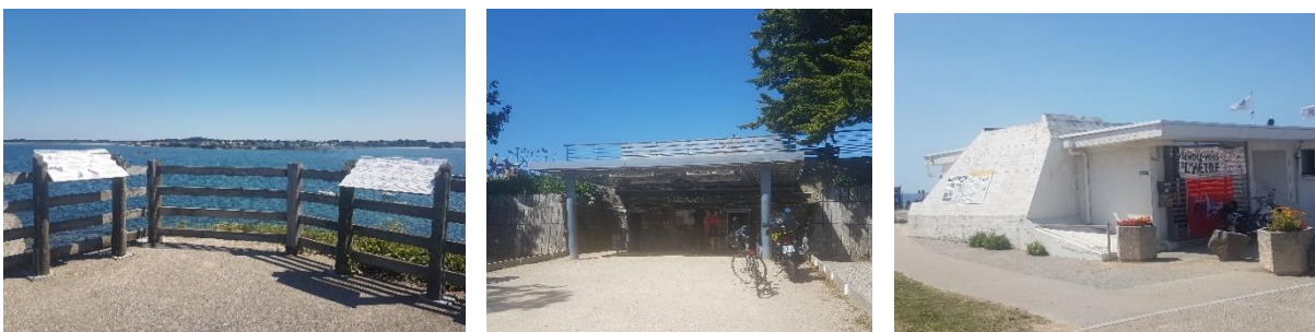
Figure 14 : Les bunkers réinvestis : Mesquer, Le Croisic, Préfailles (Koncz, 2021)
