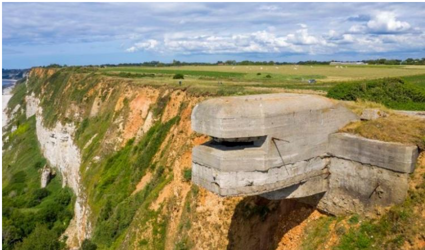
Figure 4 : Le bunker "suspendu" à Heuqueville (Guillaume Lefebvre, 2020)
