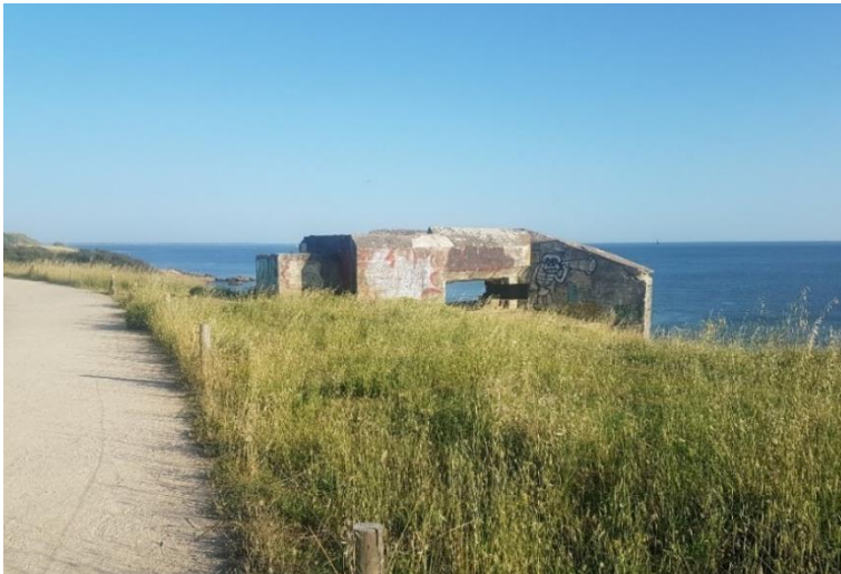
Figure 24 : Bunker sur le littoral de Pornichet : État initial en 2005 (Phytolab, 2005), Projet de belvédère non réalisé (Phytolab, 2005), État d'aujourd'hui, le bunker abandonné avec son environnement renaturé (Koncz, 2021)
