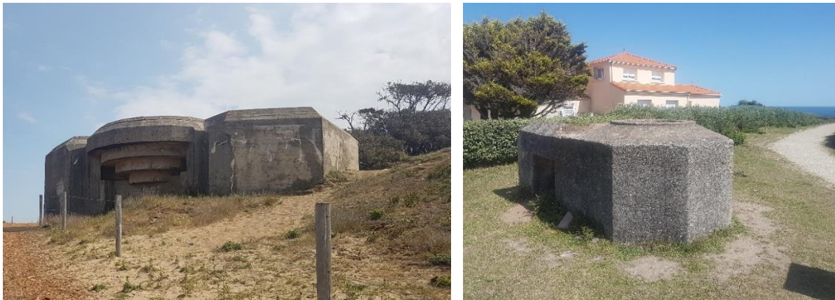
Figure 2 : Casemate (M272) à Saint-Brevin-les-Pins et tobrouk à Préfailles (Koncz, 2021)
